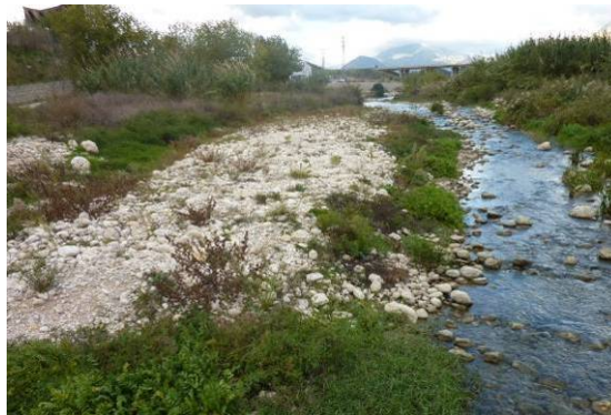
Barra lateral de bloques y gravas aguas abajo del puente de la autopista A-7.
