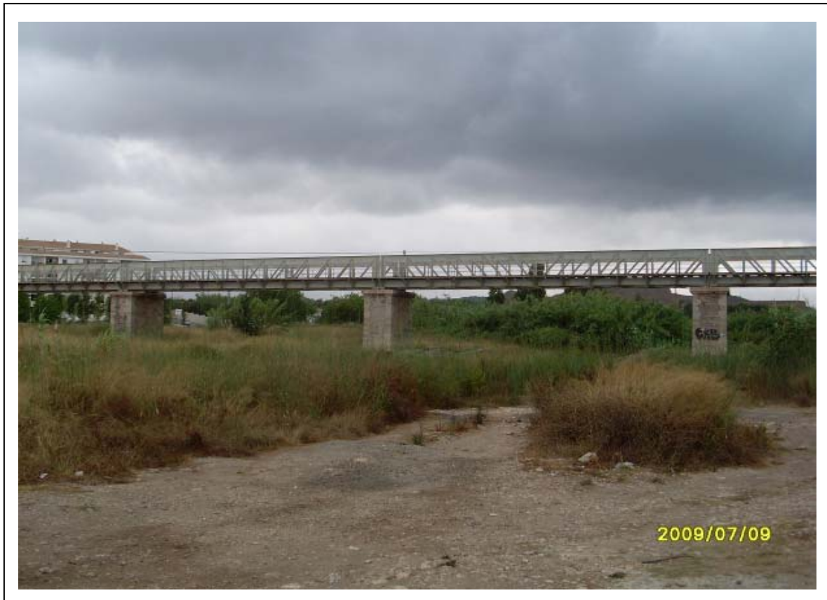
Paso ALT-103. Se trata del ferrocarril Alicante –Denia.
