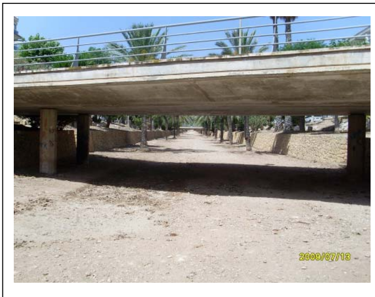
Vista de la obra de paso. ALF-115
