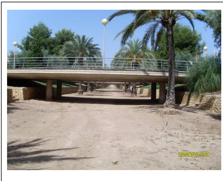
Vista de la obra de paso. ALF-114
