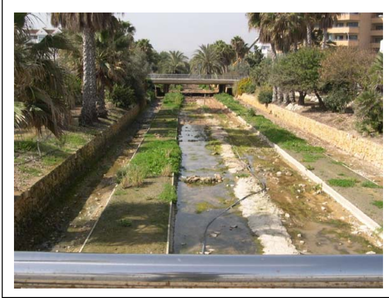
Vista de la sección del cauce del Bulevar de los Músicos.
