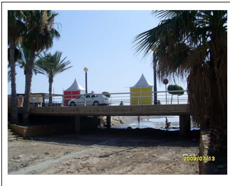
Vista de la obra de paso. ALF-113
