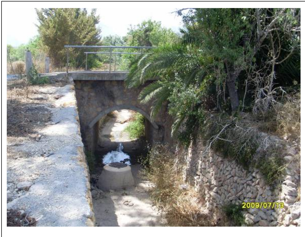
Vista de la obra de paso ALF-111 desde aguas abajo
