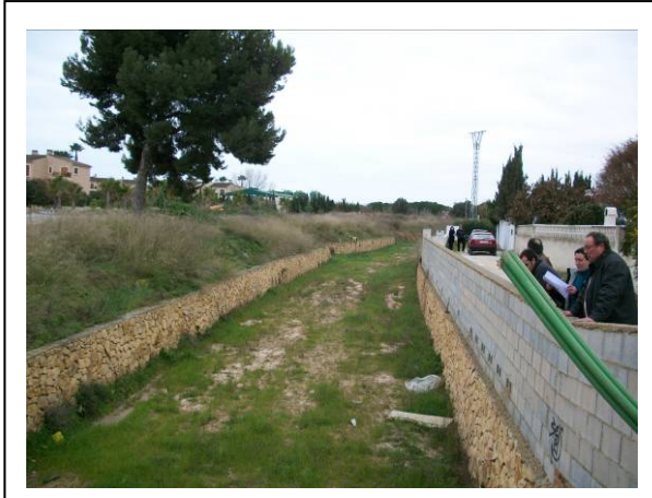
Vista del tramo encauzado desde la obra de paso ALF106
