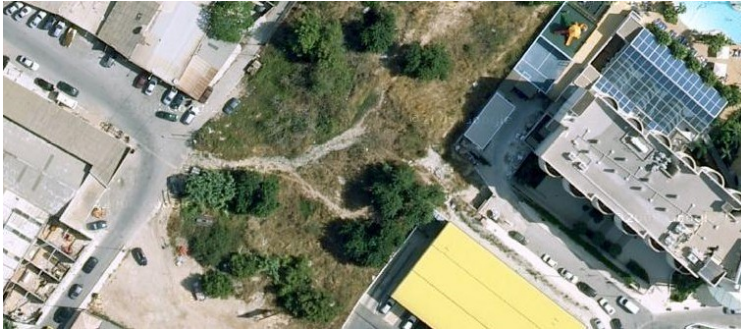
Derrame de sedimentos en el final de la rambla de l'Albir, entre la zona industrial y el hotel Albir playa.
