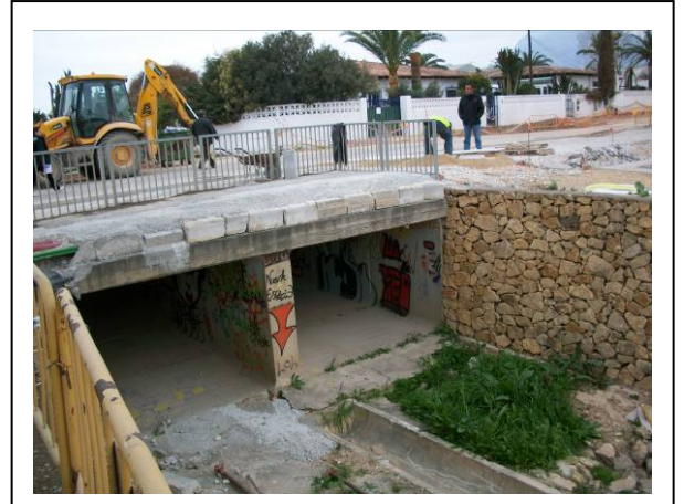
Vista desde aguas abajo de la obra de paso ALF-106
