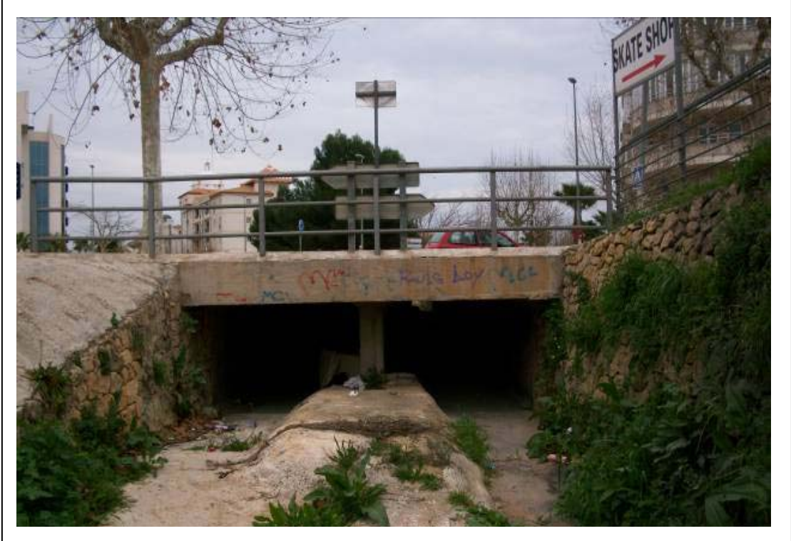
Vista del paso inferior del barranco en la glorieta de confluencia. ALF-105
