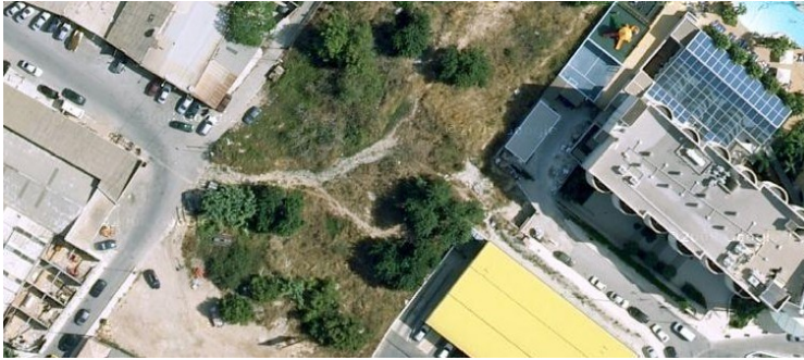
Derrame de sedimentos en el final de la rambla de l'Albir, entre la zona industrial y el hotel Albir playa.
