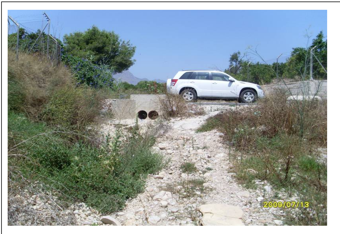
Vista del badén desde aguas abajo. ALF-104
