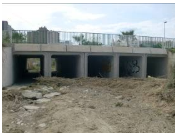
Foto 36 y 37: Puente formado por cinco marcos en avenida Rumania, a la derecha se observa como el campo invade varios metros el cauce restringiendo su sección antes de atravesar el puente.
