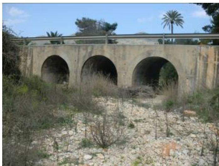
Foto 6: Puente sobre barranco de Masserof en CV-750.
