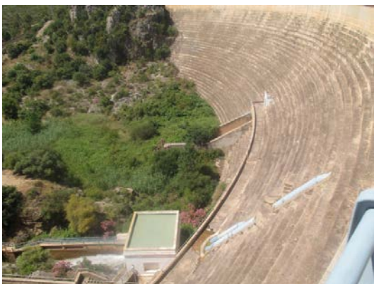
Fotografía 6 Exteriores – Caseta toma agua y acceso desagüe fondo
