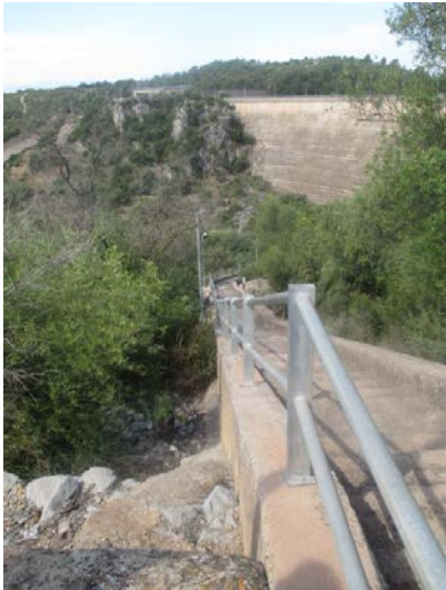
Fotografía 22 Exteriores – Escalera – Acceso desagüe fondo
