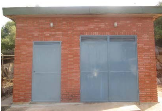
Fotografía 20 Exteriores – Edificio GE - Acceso
