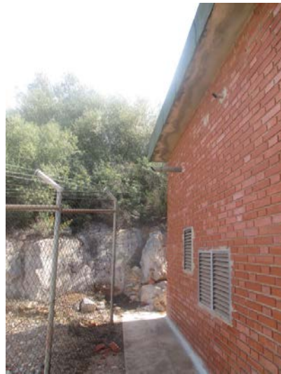
Fotografía 21 Exteriores – Edificio GE - Ventilación
