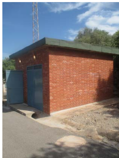
Fotografía 19 Exteriores – Edificio GE – Arqueta eléctrica
