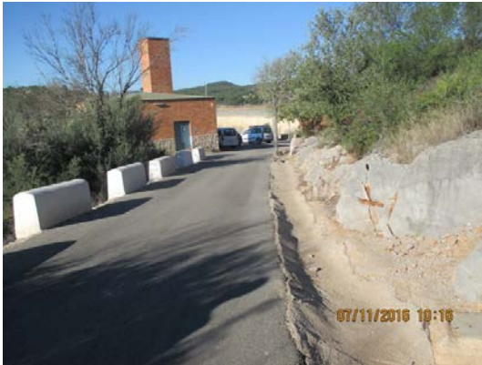
Fotografía 16 Exteriores – Acceso presa
