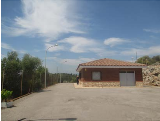
Fotografía 14 Exteriores – Casa Administración – Acceso almacén
