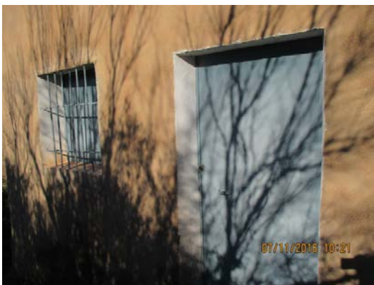
Fotografía 18 Exteriores – Edificio CT y CGBT – Canalización acceso planta sótano
