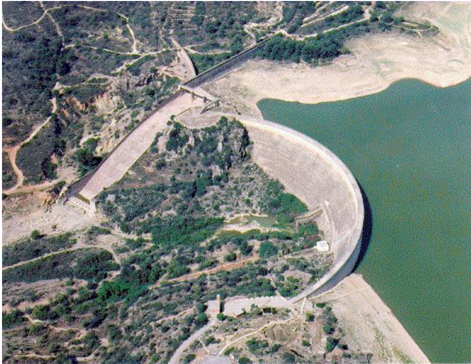
Presa de María Cristina. Vista desde aguas abajo
