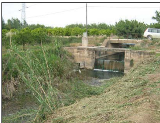
Foto 1: Efecto barrera de la compuerta para derivación de agua de riego en el nacimiento del río Verde
