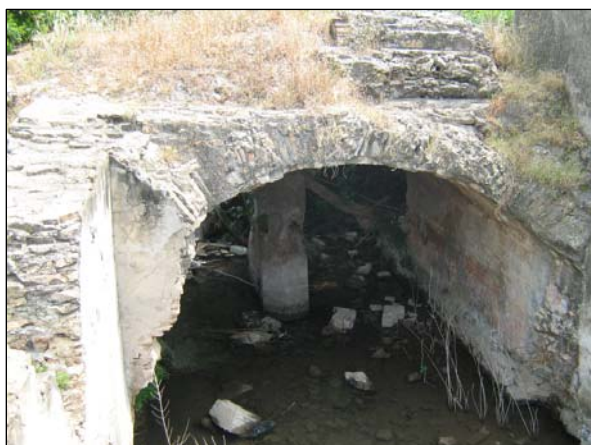
Foto 2: Molino en ruinas aguas abajo del puente de la A-7
