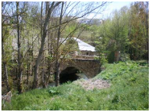
7.- PUENTE DE PIEDRA SOBRE EL CAUCE DEL OJOS DE MOYA
