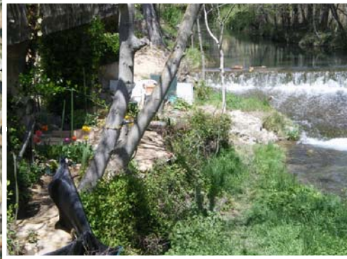
9.- EDIFICACIÓN OCUPANDO EL MARGEN DERECHO DEL CAUCE
