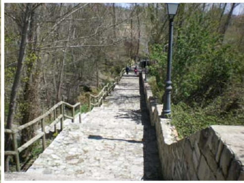
4.- ESCALERAS EN LA RIBERA DERECHA DEL ÁREA RECREATIVA DE LANDETE
