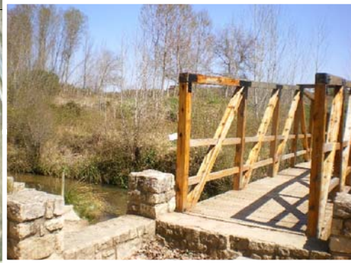
5.- PUENTE DE MADERA EN EL ÁREA RECREATIVA DE LANDETE
