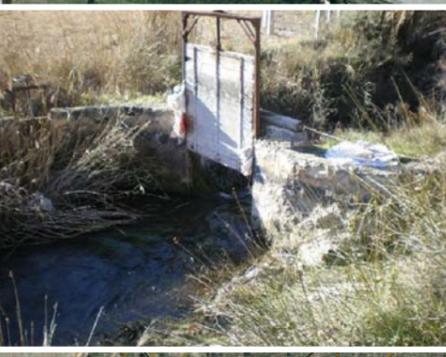
39- COMPUERTA PARA EXTRACCIÓN DE AGUA PARA RIEGO
