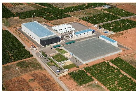
Desaladora de Moncofa. Fuente: Acuamed
