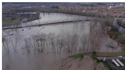
Funcionamiento de la llanura inundable en el río Júcar a su paso por la ciudad de Cuenca. Obras de Restauración de ribera y disminución del riesgo de inundación del río Júcar en la confluencia con el río Moscas (T.M. Cuenca).
