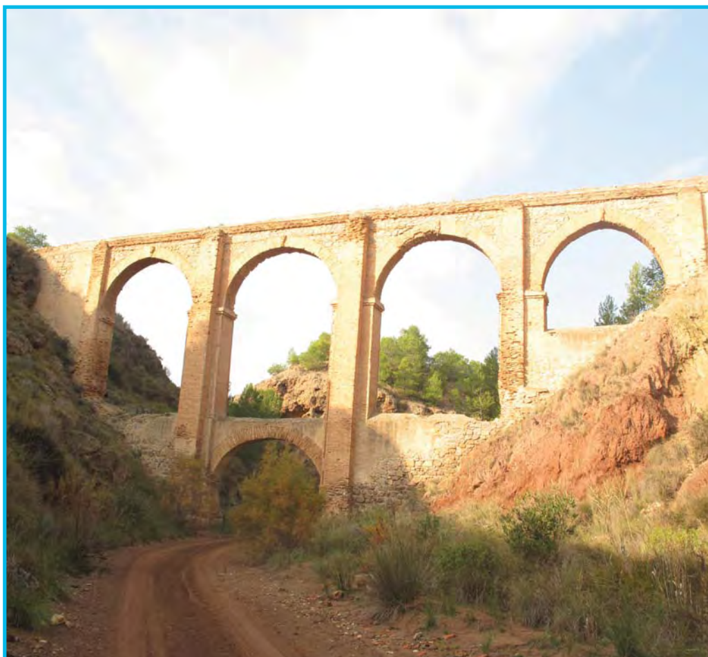
Acueducto de los Cinco Ojos, sobre el río Vinalopó, Aspe (Alicante)
