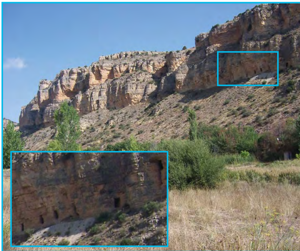
Acueducto de Cella Albarracín, Gea de Albarracín (Teruel)
