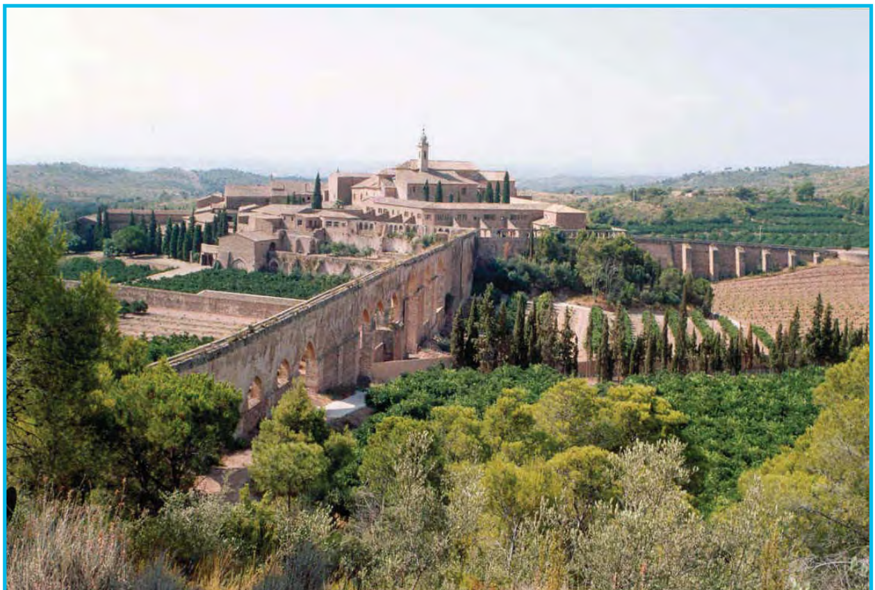
Acueducto de la Cartuja de Portacoeli, Serra (Valencia)
