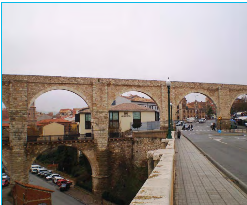
Acueducto de los Arcos, abastecimiento urbano (Teruel)
