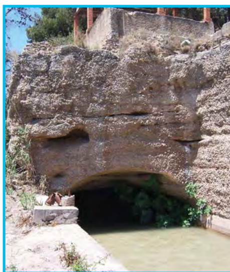
Mina de la Séquia Comuna de Castelló - Almassora. Almassora (Castellón de la Plana)
