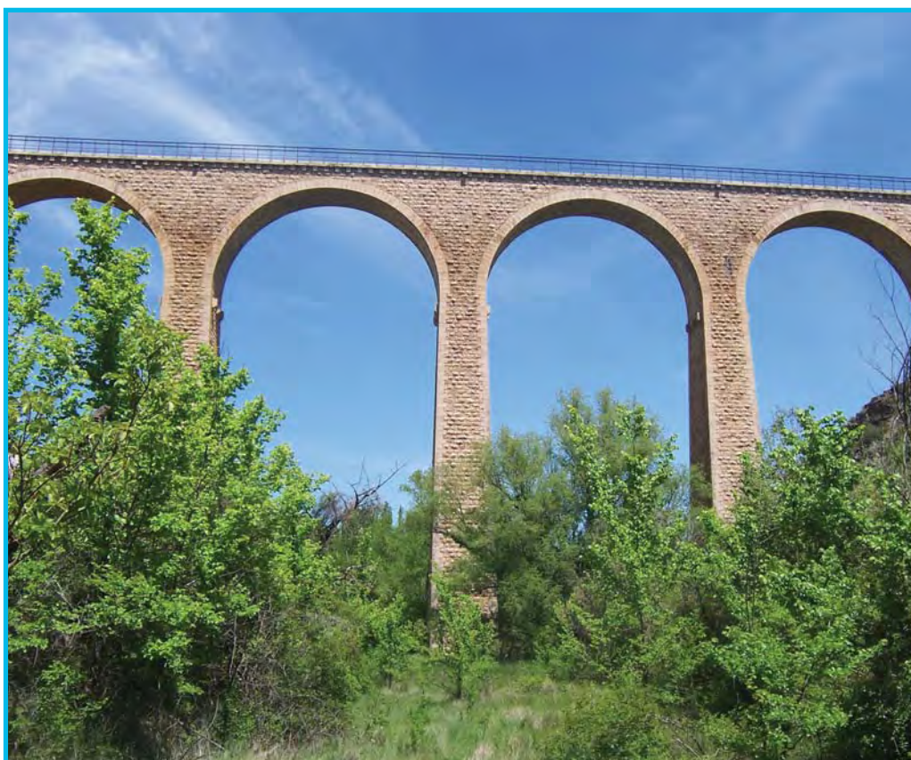
Viaducto de la Vía Verde de Ojos Negros sobre el río Albentosa, Albentosa (Teruel)
