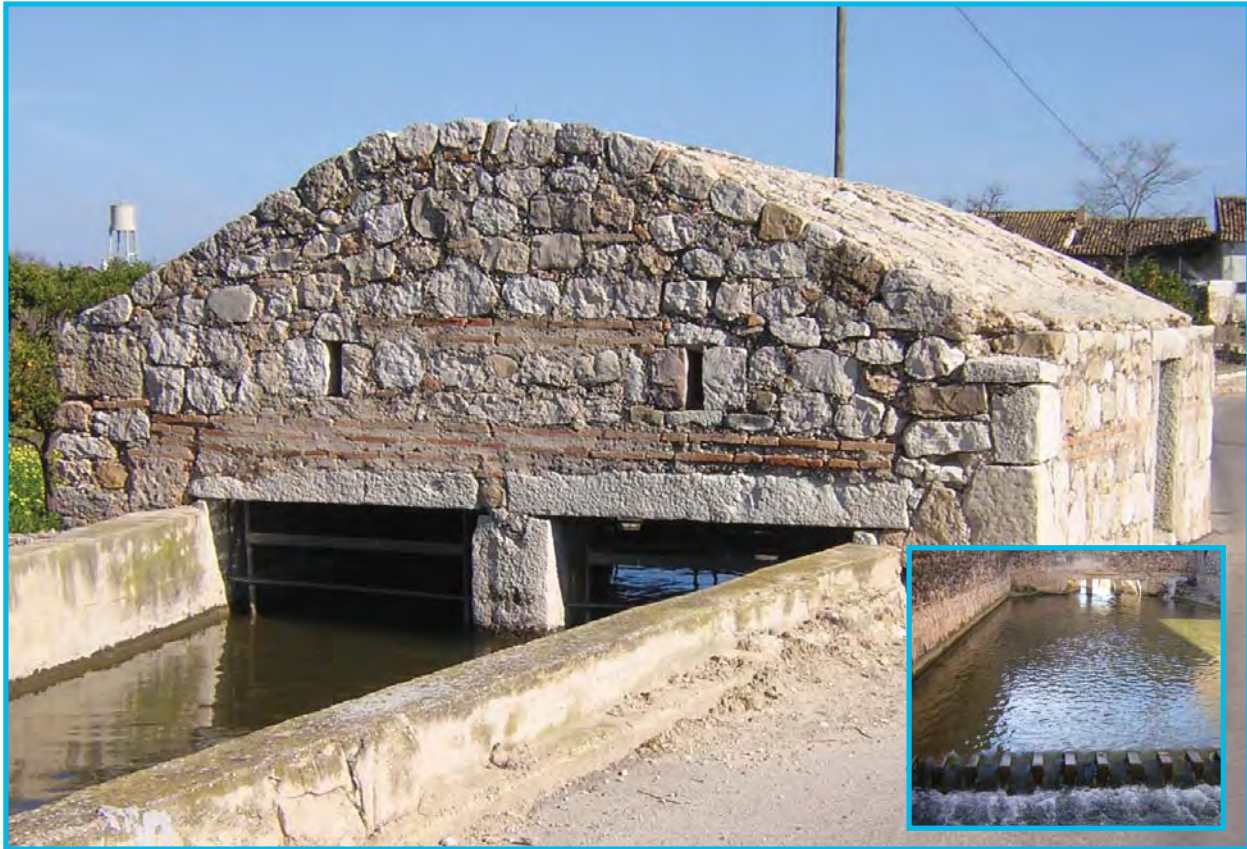
Partidor o Cano del Molí de Baix, Rafelcofer, l'Horta de Gandia (Valencia). Recuadro: Interior del partidor de la Casa Clara, Potries, l'Horta de Gandia
