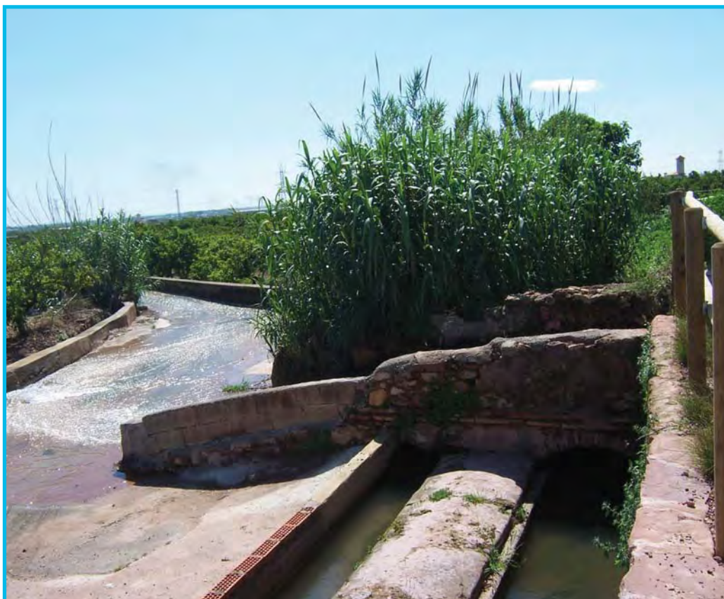
Gallipont de Faura, permite el paso de un camino y barranco sobre la acequia, Faura (Valencia)
