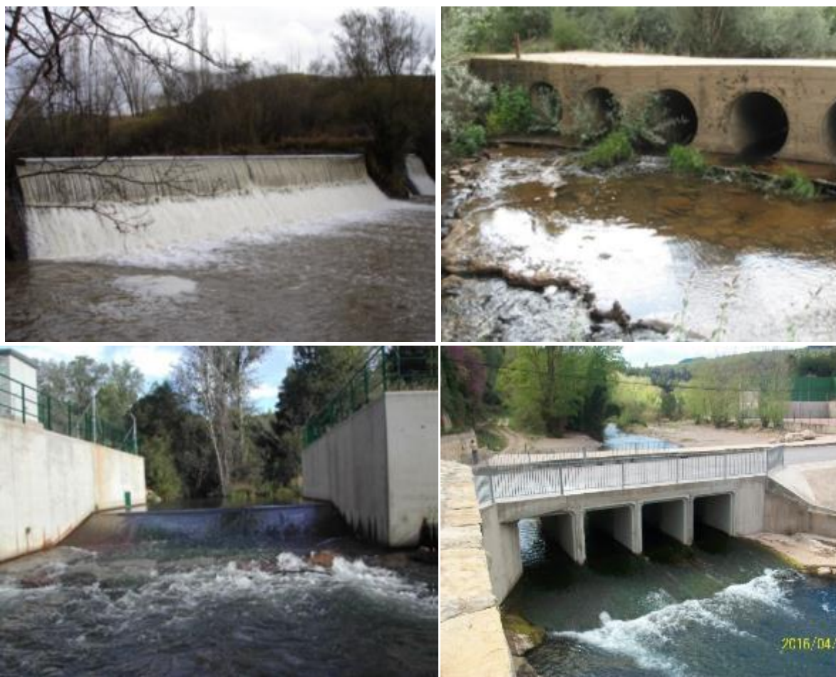
Figura 8: Ejemplo de obstáculos (de arriba a abajo y de izquierda a derecha): salto vertical, paso entubado mixto, pa sobre paramentos, obstáculo mixto
