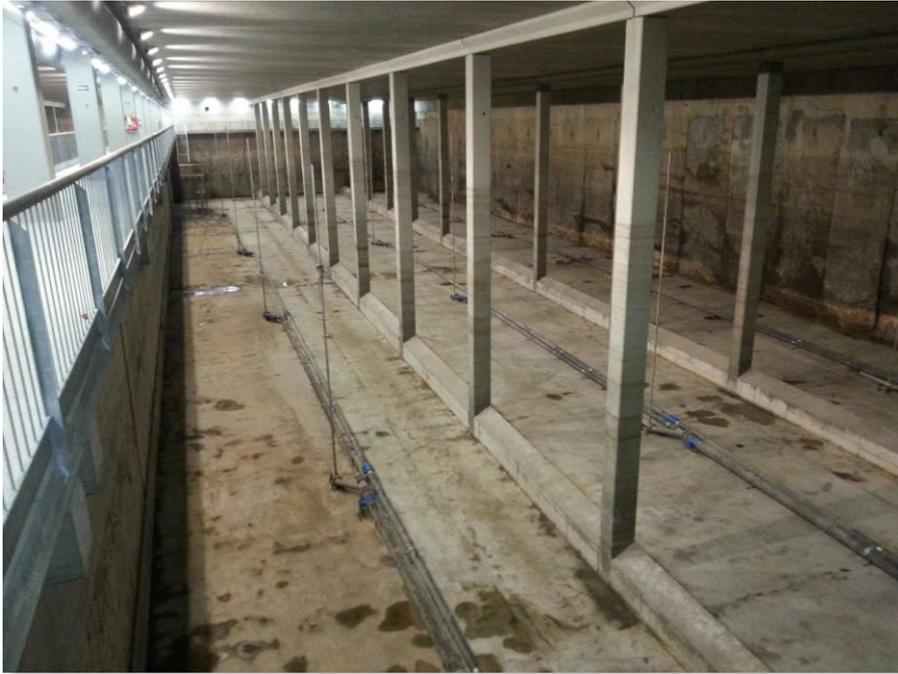
Figura 77. Cámara de retención del tanque de tormenta José Manuel Obrero (Alicante). (MAGRAMA, 2014).
