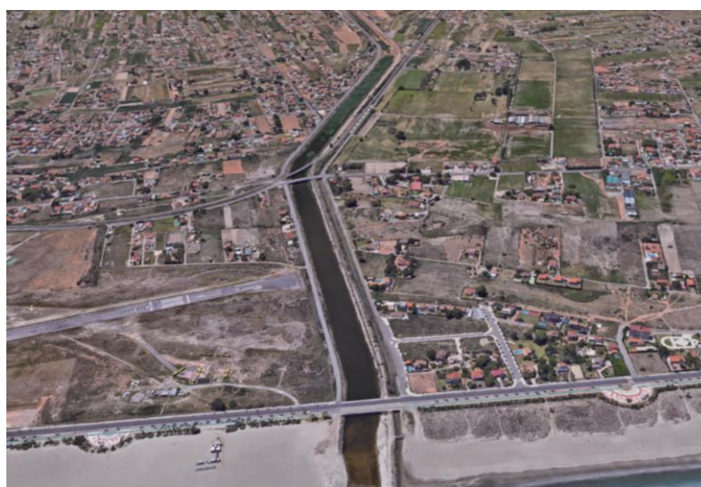
Figura 11. Vista aérea del encauzamiento del río Seco en su desembocadura (Fuente: GoogleEarth)
