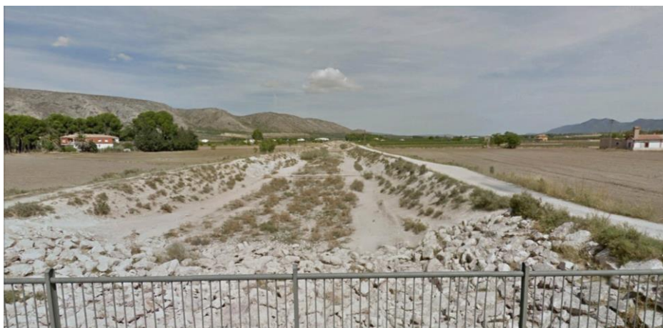
Figura 13. Encauzamiento del río Vinalopó a su paso por Villena (Fuente: GoogleEarth)
