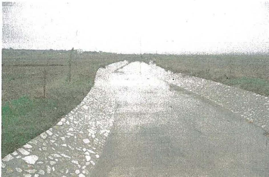
A su paso por el municipio el cauce del río se encuentra hormigonado en la base y chapado de piedra en sus paredes laterales.
