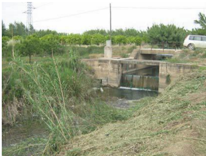
Figura 19: Efecto barrera de la compuerta para derivación de agua de riego en el nacimiento del río Verde
