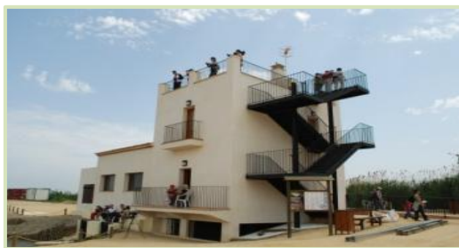
Figura 49. Obras Uso público en el Tancat de la Pipa
