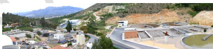
Figura 5. Vista general EDAR de Benidorm
