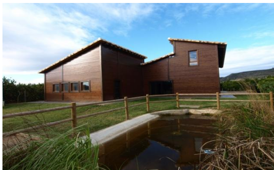
Figura 48. Obras Uso público en la marjal de Gandía
