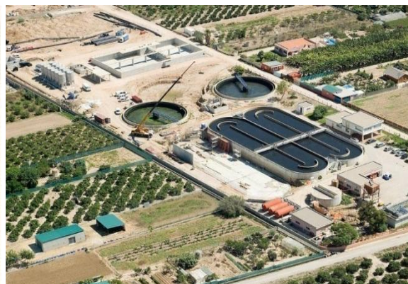
Figura 12. -Ampliación de la EDAR de Sueca (Valencia)
