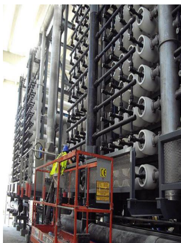
Figura 41. Montaje bastidores en la IDAM Mutxamiel
