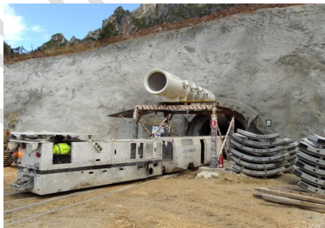
Figura 27. Ejecución de las obras en el Tramo B de la conducción principal
