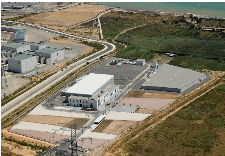
Figura 44. Vista aérea planta de tratamiento. IDAM Sagunto
