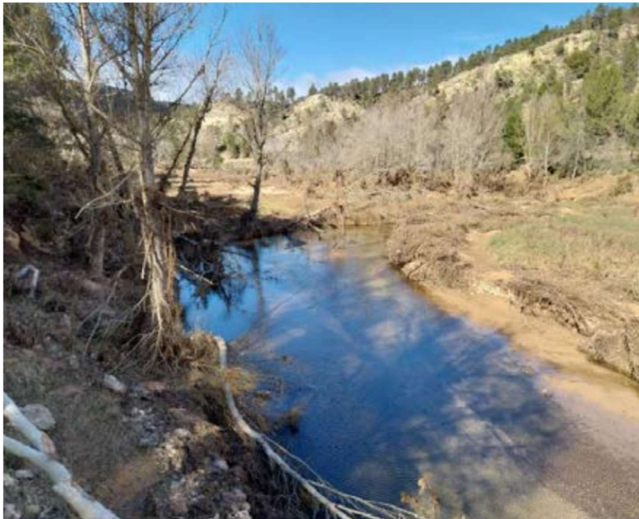
- Restauración de cauces y estabilización de márgenes -
