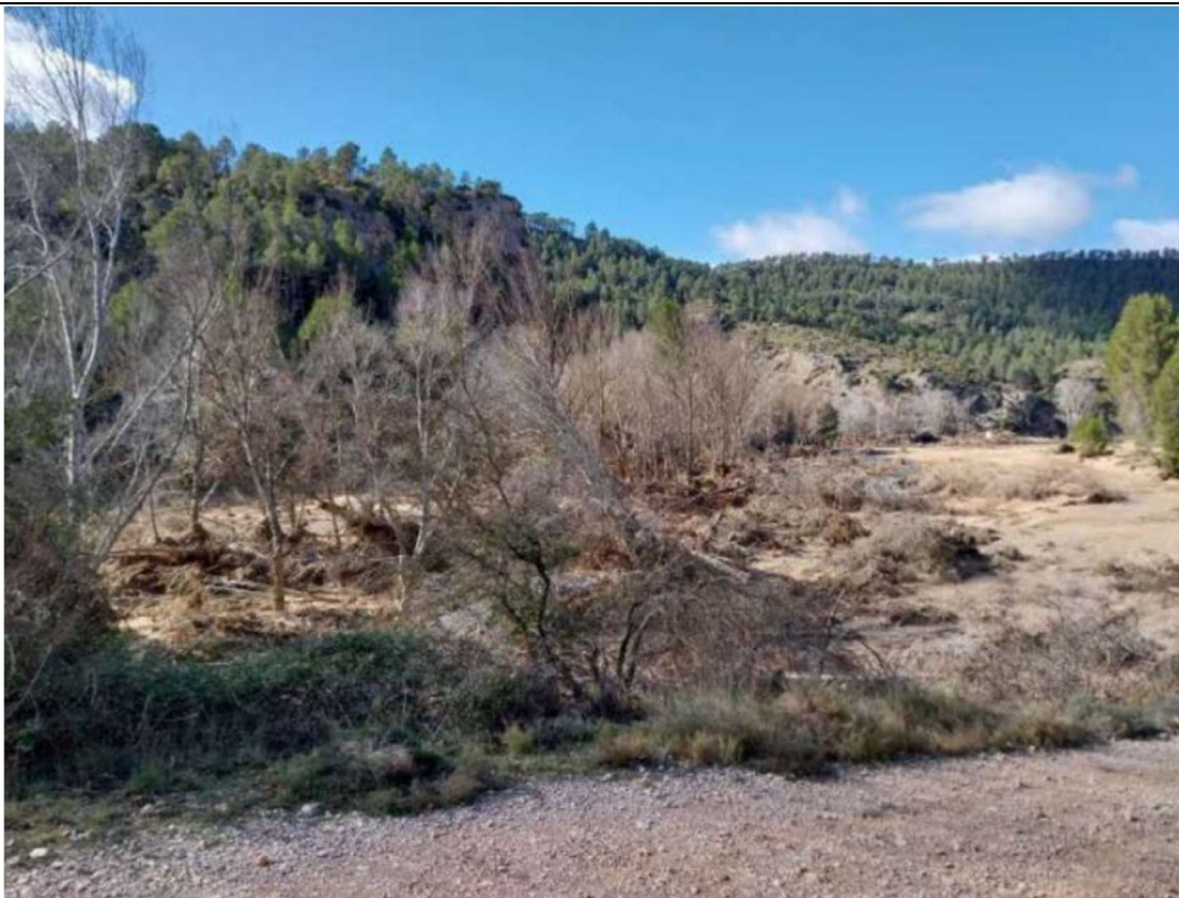
- Restauración de cauces y estabilización de márgenes -
