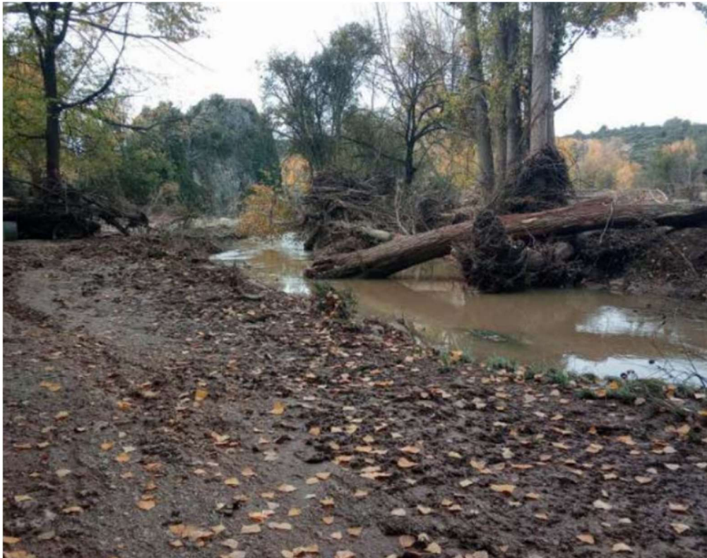
- Restauración de cauces y estabilización de márgenes -
