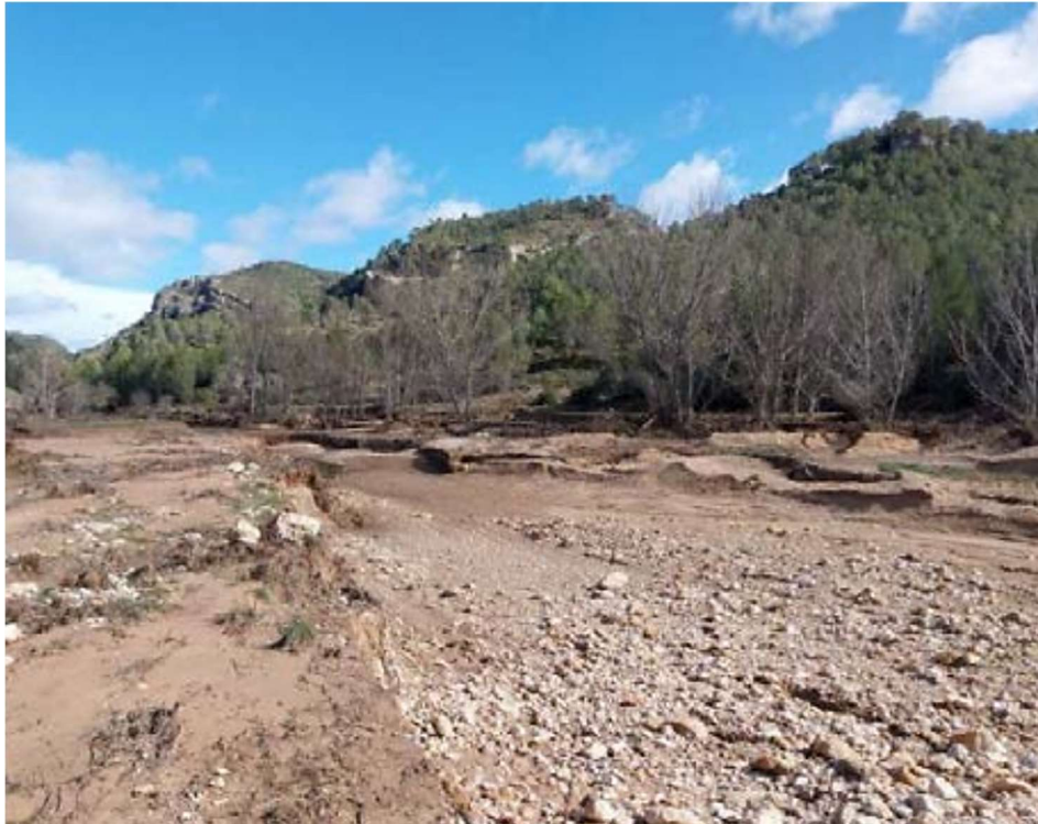
- Restauración de cauces y estabilización de márgenes -
