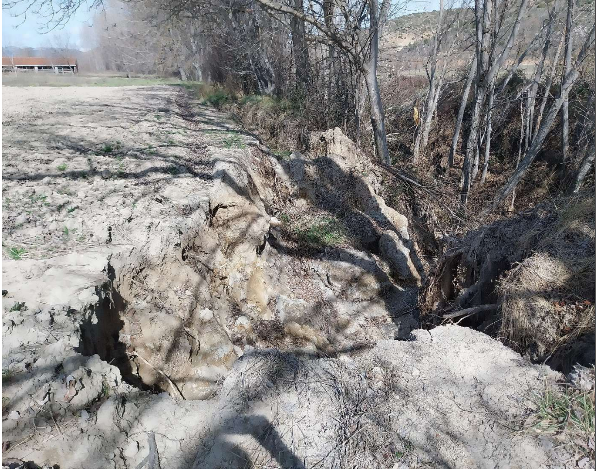
- Restauración de cauces y estabilización de márgenes -
