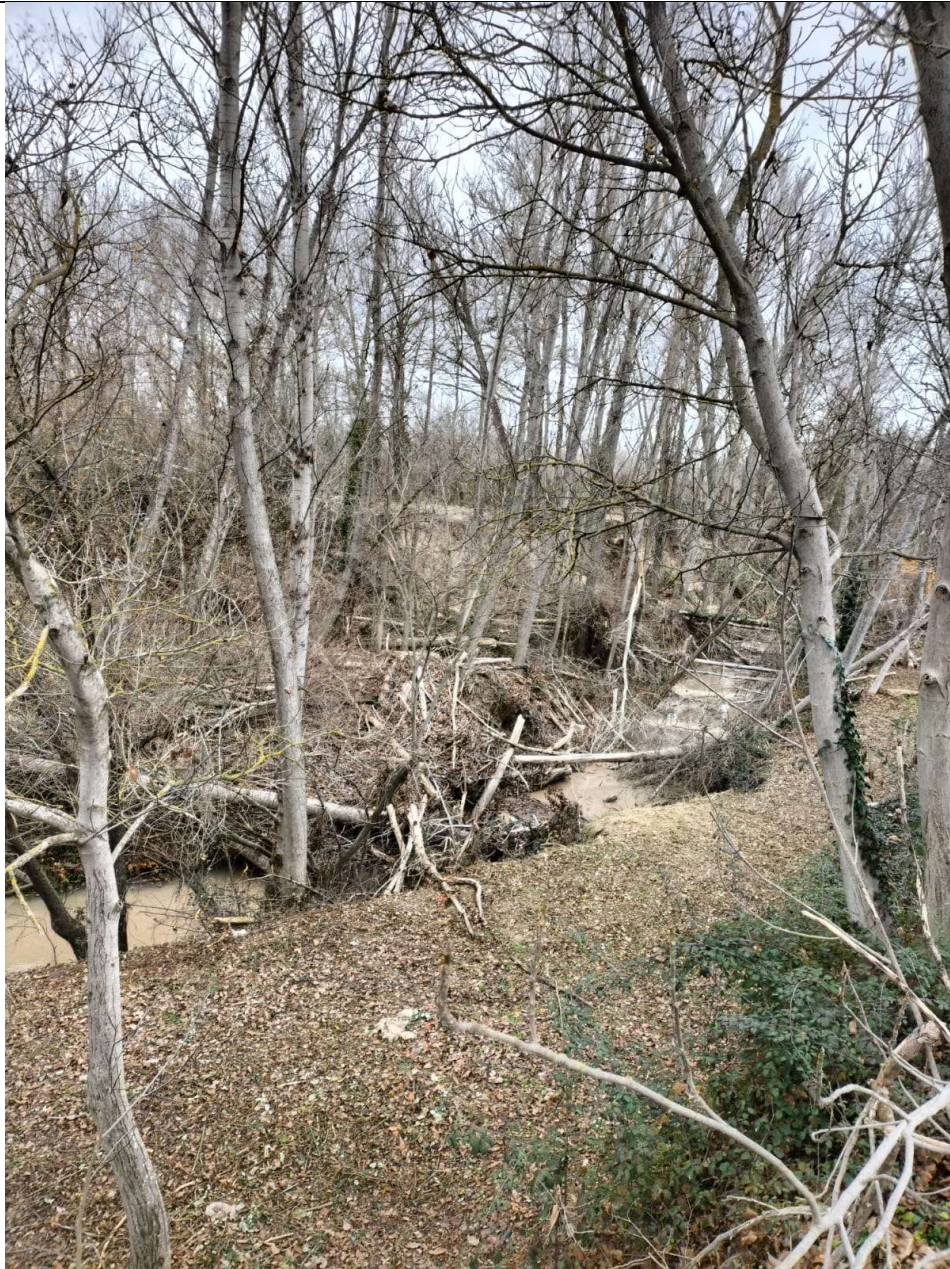
- Restauración de cauces y estabilización de márgenes -
