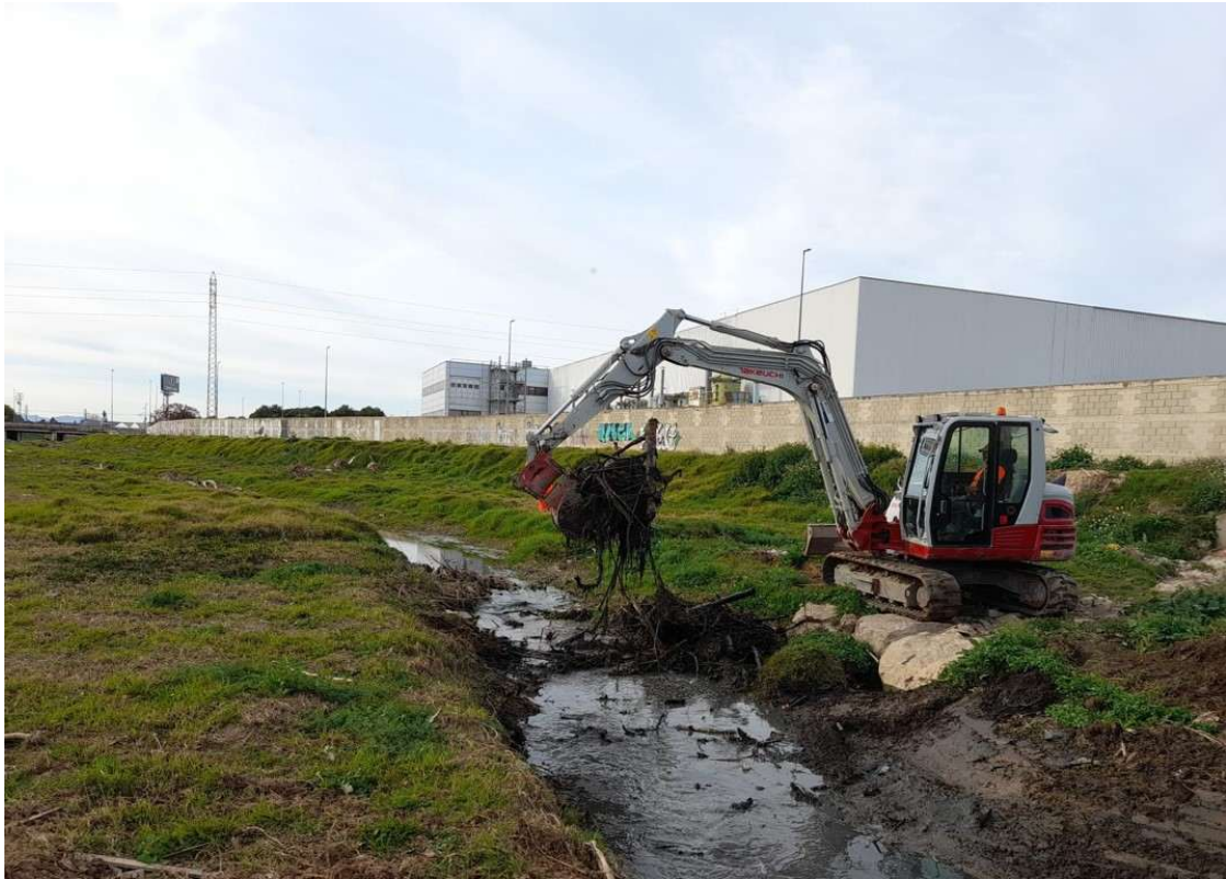
- Retirada de elementos obstructivos en el Barranco Picassent, Beniparrell -
