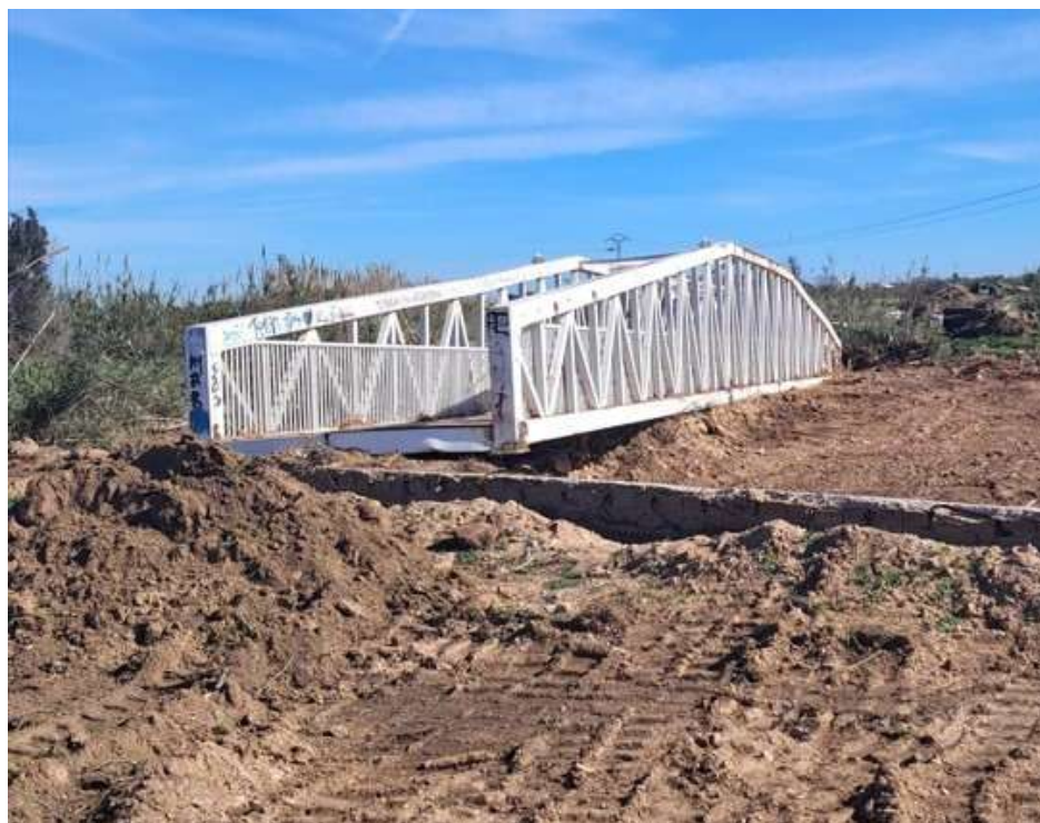
- Retirada de elementos obstructivos en el Barranco Picassent, Alcàsser -
