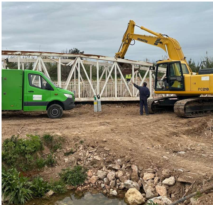
- Retirada de elementos obstructivos en el cauce del Barranco Picassent, Alcàsser -
