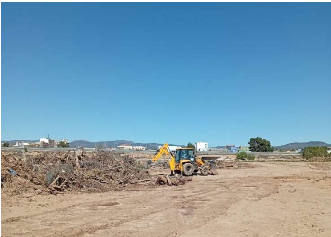
- Retirada de elementos obstructivos en el cauce en el río Magro, Utiel -
