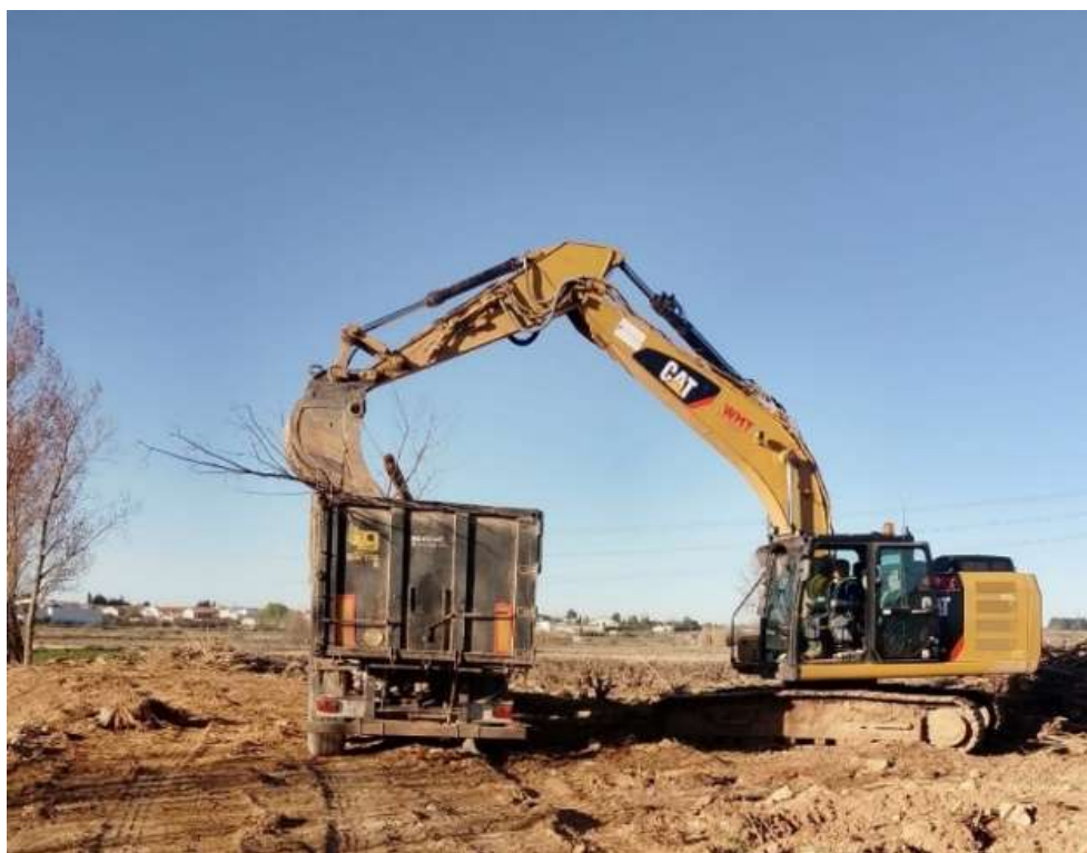
- Retirada de elementos obstructivos en el cauce de la Rambla Casa Nueva, Requena -
