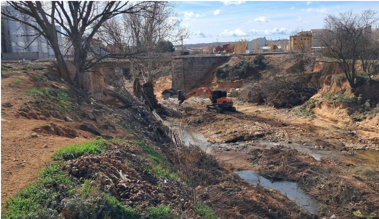
- Retirada de elementos obstructivos en el cauce del Barranco de San Antonio, Requena -
