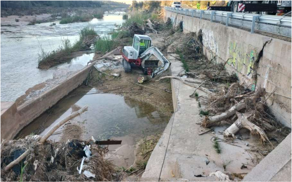
- Retirada de elementos obstructivos en el azud de Llombai -
