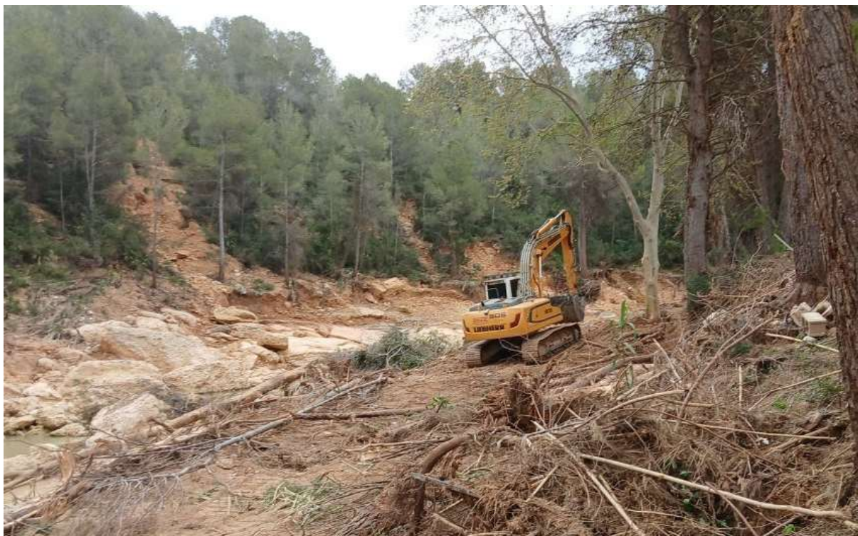
- Trabajos de corte, acopio y traslado a gestor de los árboles caídos en Barranco del Gallego, Godolleta -
