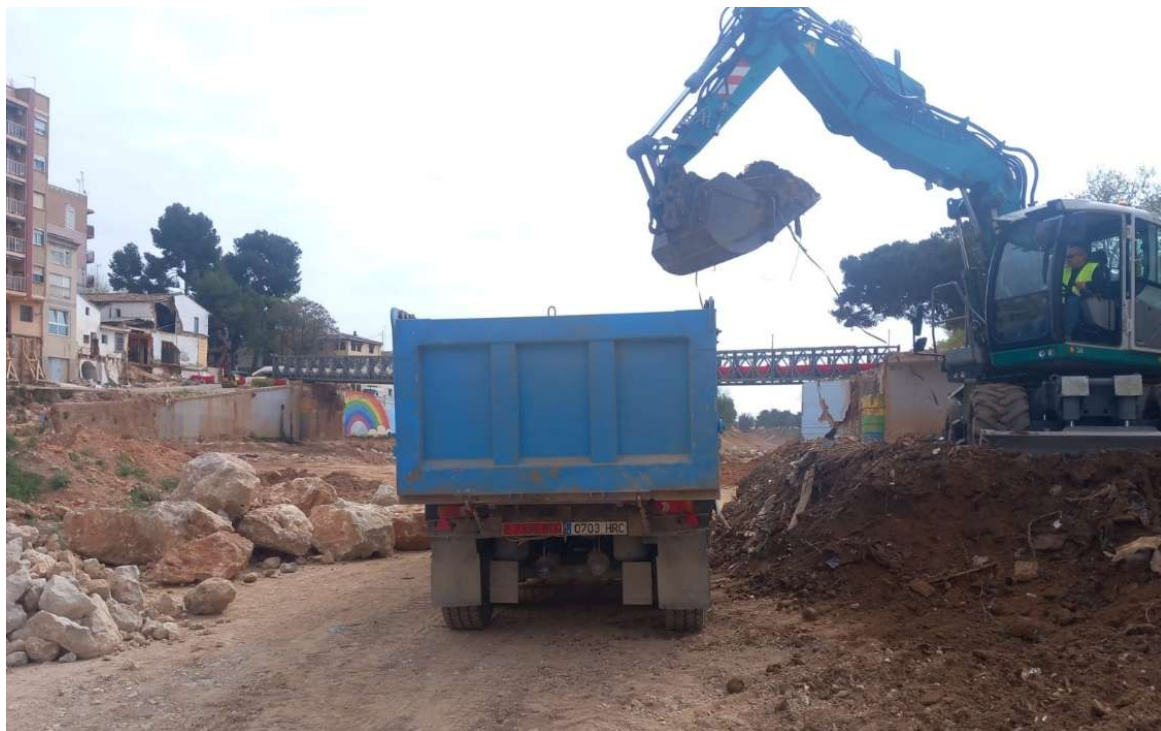
- Retirada de los acopios de material en el Barranco del Poyo, Picanya -
