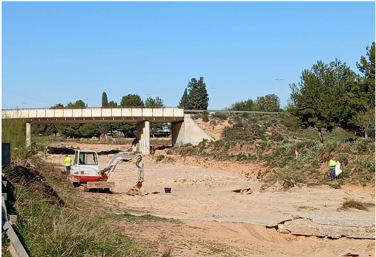
- Retirada de elementos obstructivos en el cauce del Barranco de la Saleta, Aldaia -
