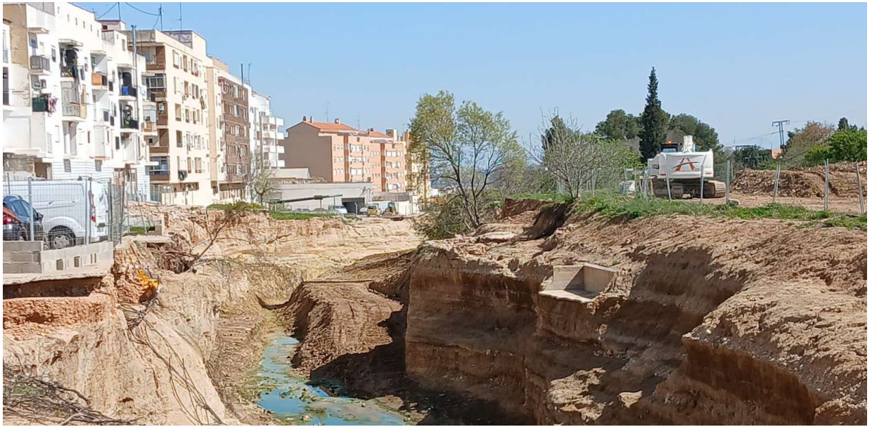
- Retirada de elementos obstructivos en el cauce del Barranco del Poyo, Chiva -
