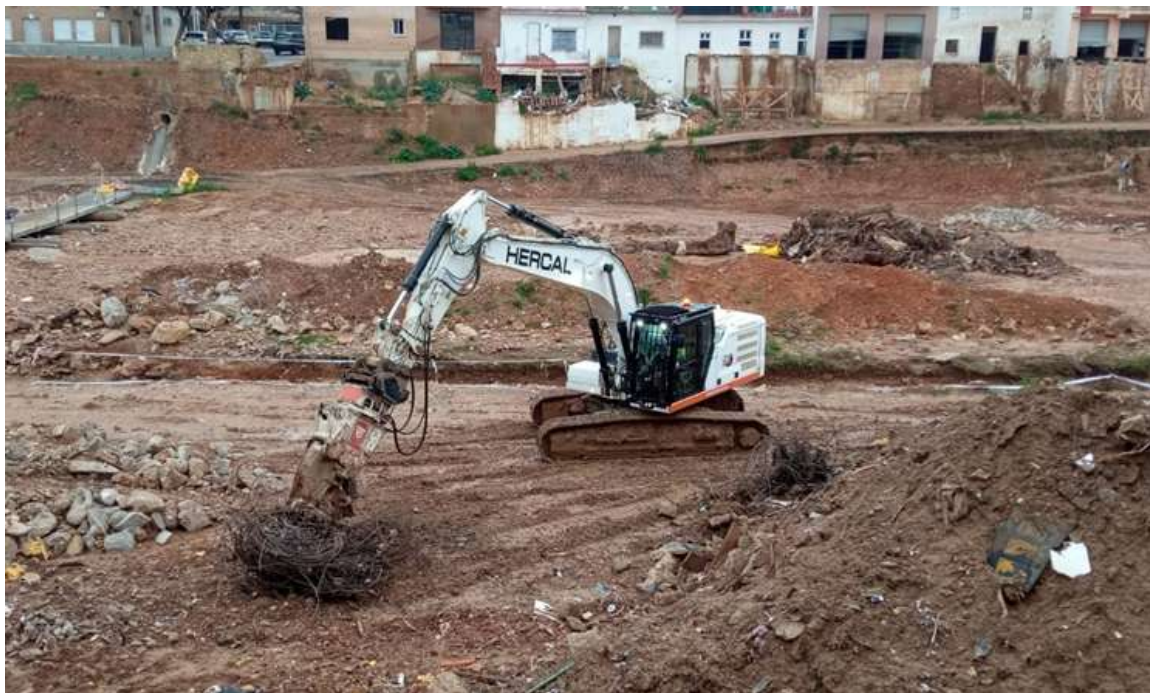
- Apertura de cauce en el Barranco del Poyo, Picanya -
