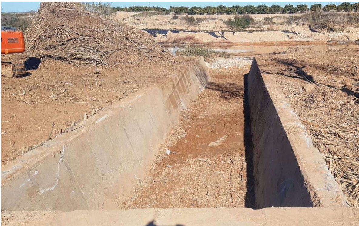
- Retirada de elementos obstructivos en el Barranco de los Porxinos, Ribarroja de Turia-
