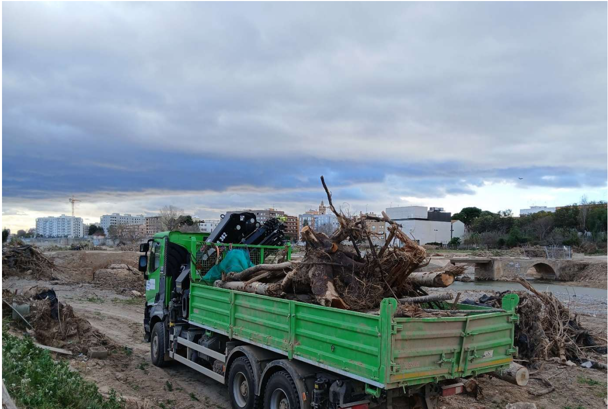
- Retirada de elementos obstructivos en el cauce del río Turia, Quart de Poblet -
