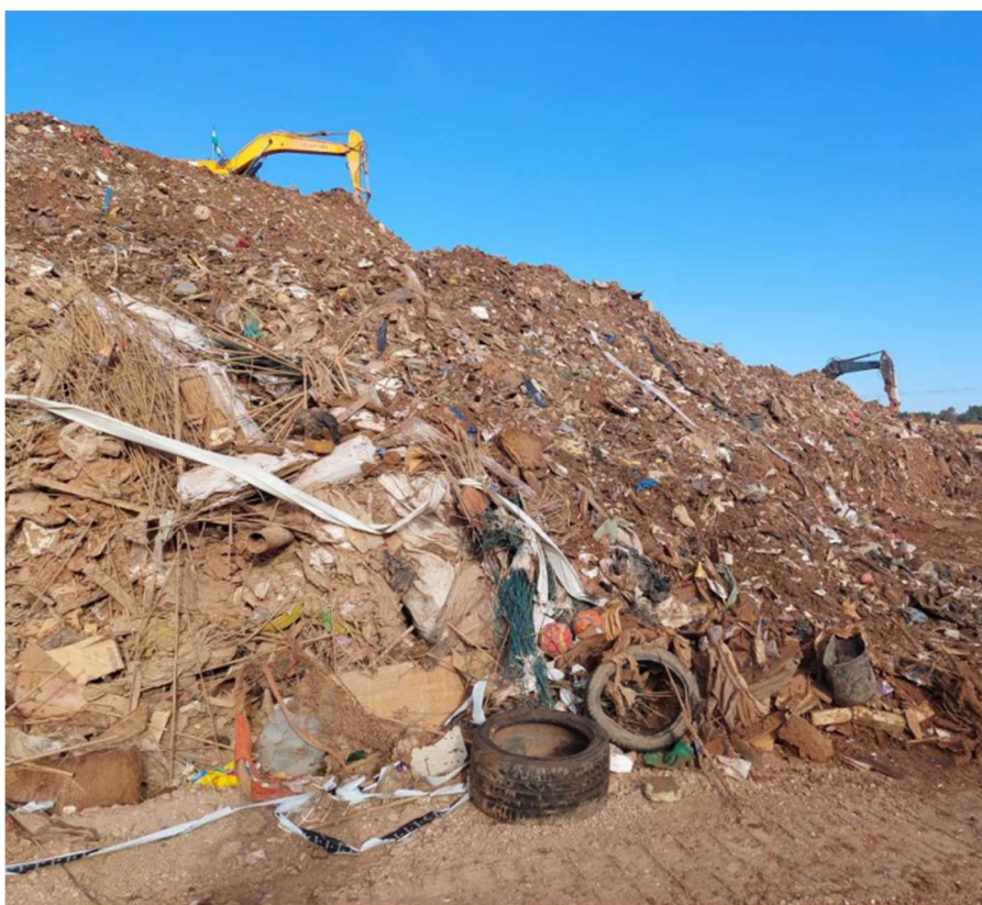
- Zona de acopios en Quart de Poblet -
