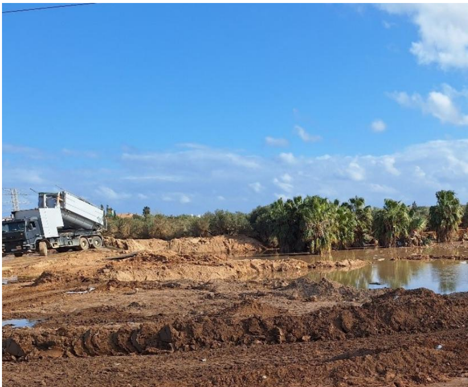
- Zona de acumulación de lodos extraídos de alcantarillado en el Barranco del Poyo -
