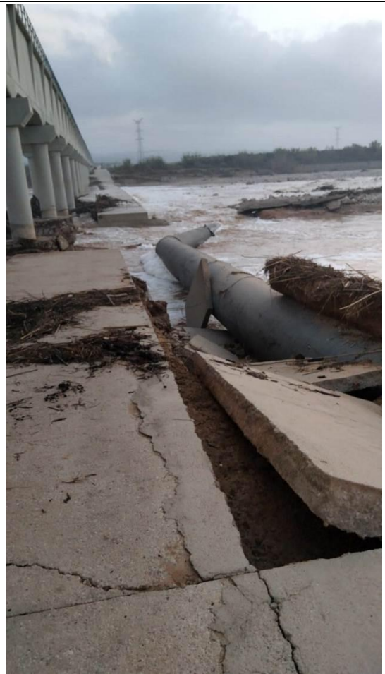
-Estado del by-pass del Magro-
