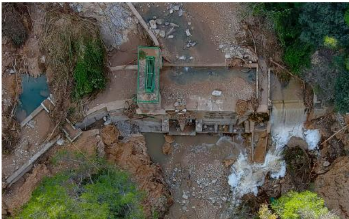
Estado del CCT en Barchel II (PK 2+650)
