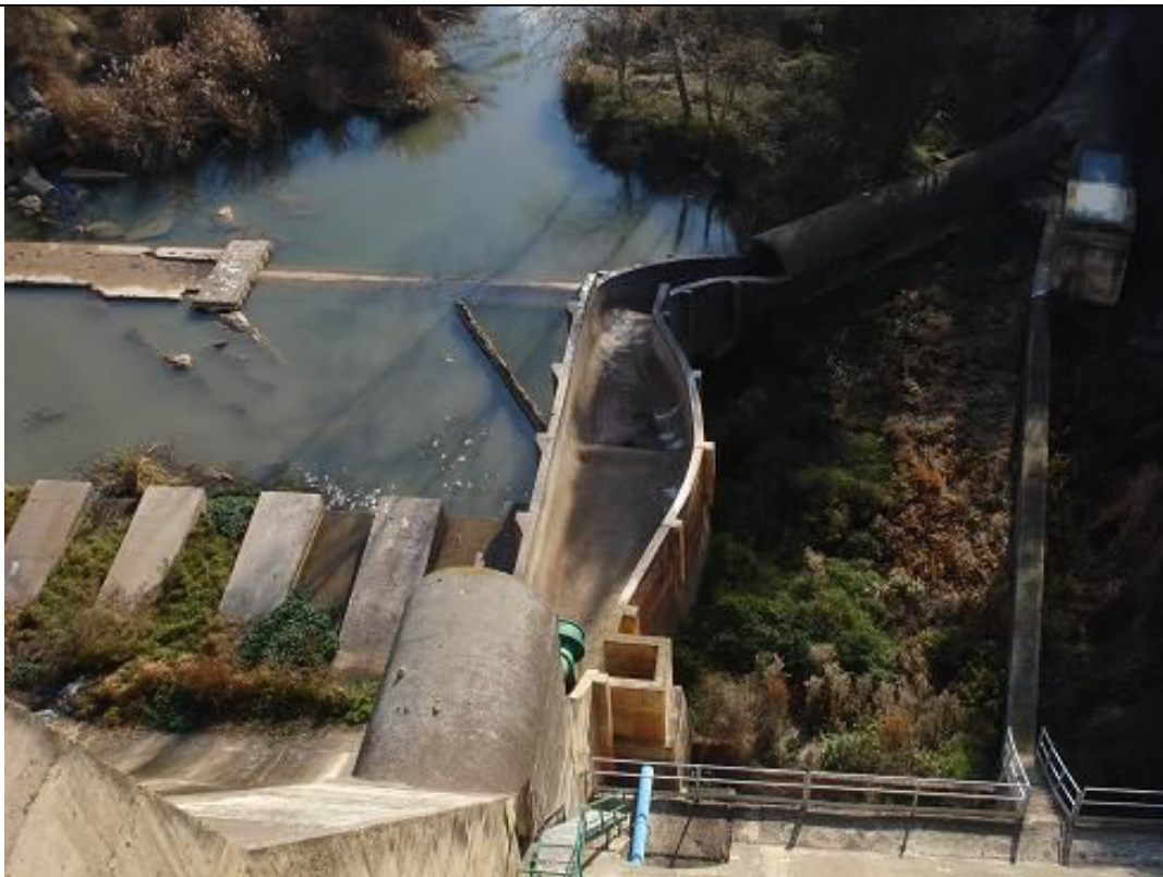
Vista aguas hacia aguas abajo toma margen derecha
