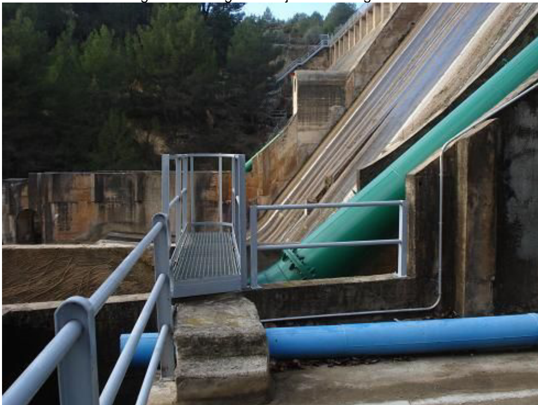
Vista lateral del parámetro de aguas abajo. Toma de margen izquierda en primer plano
