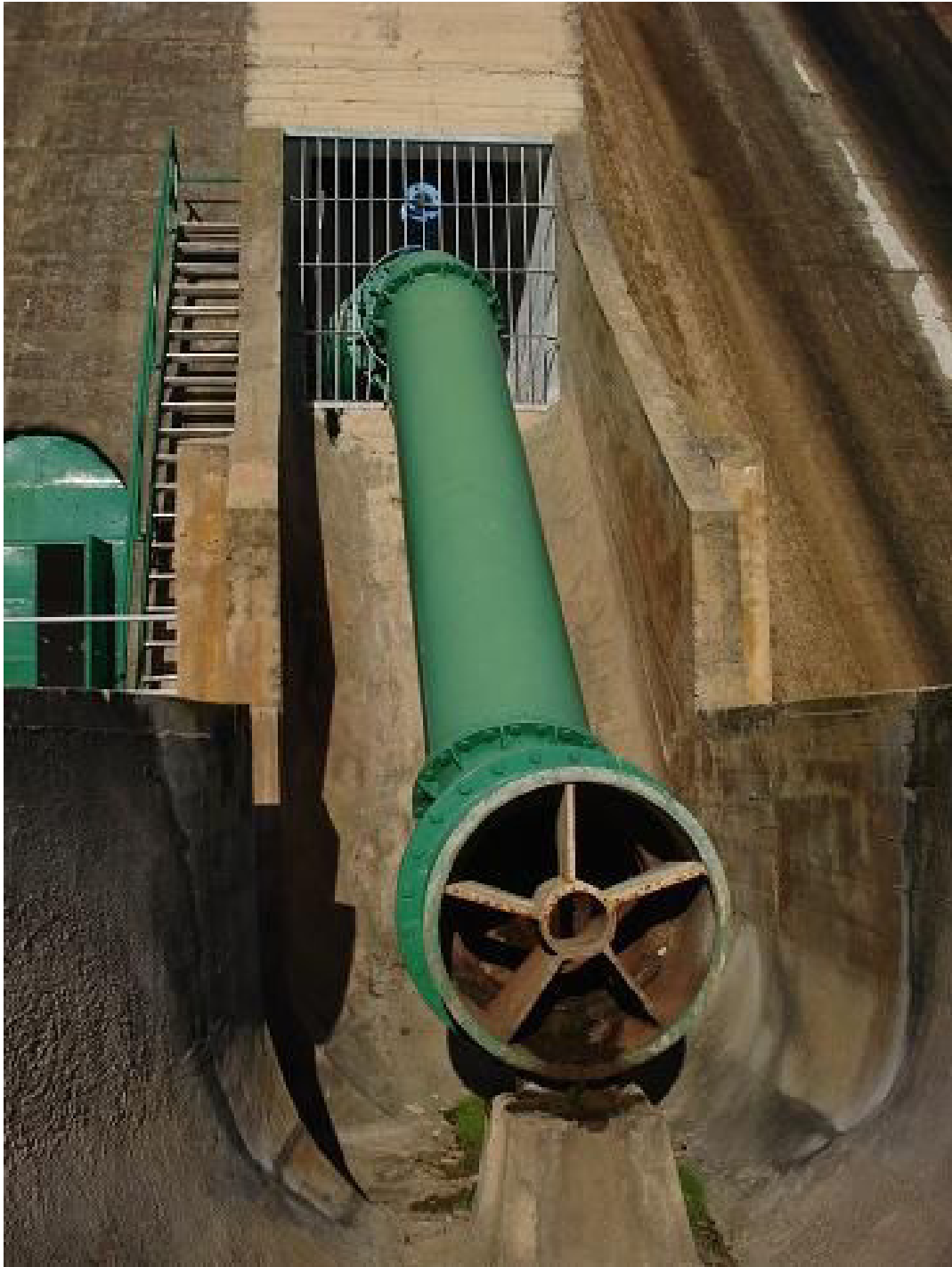
Estado Actual toma de margen derecha
