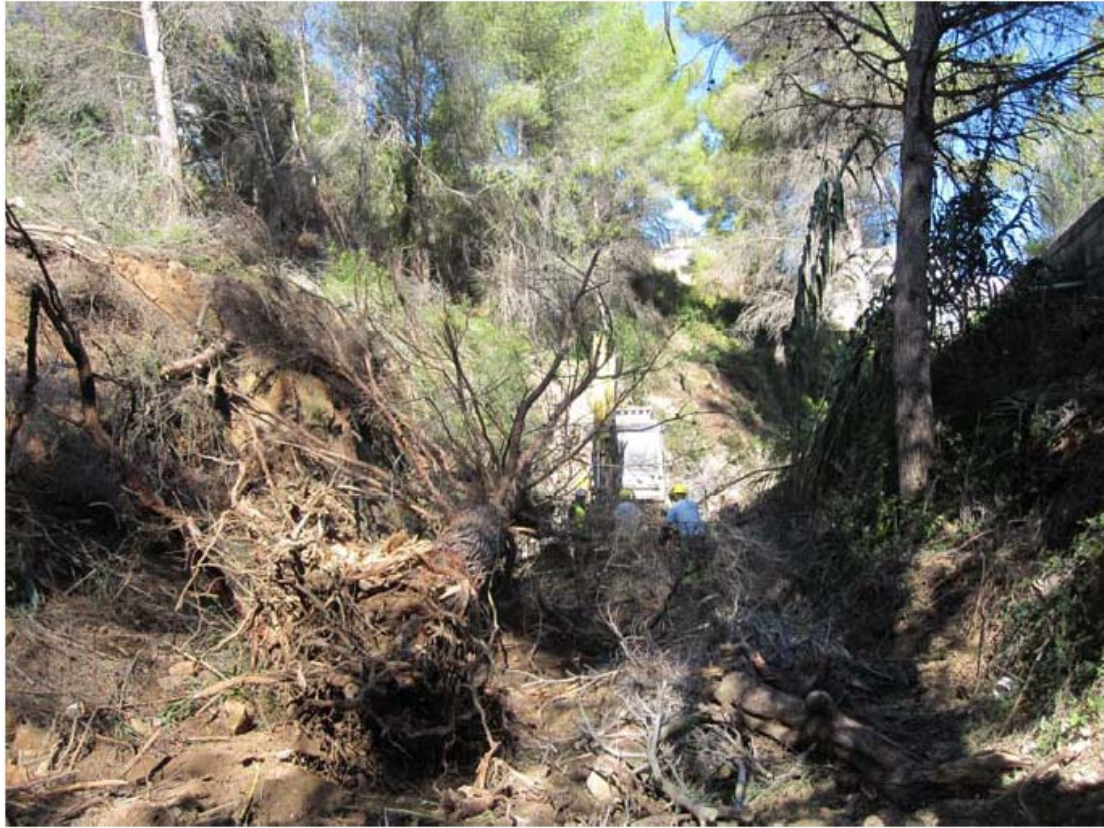
Detalle de los trabajos selvícolas efectuados en el curso medio.
