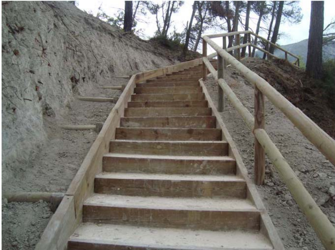
Nuevo tramo de senda construido para evitar zona de deslizamientos.
