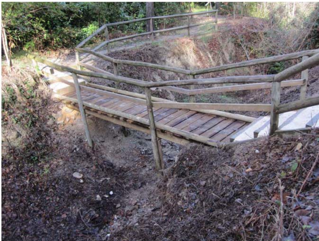
Saneado de pasarela preexistente.
