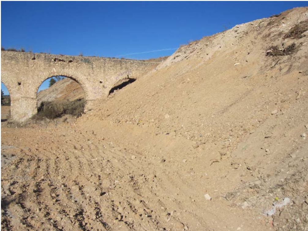
Estado final del talud junto acueducto existente.
