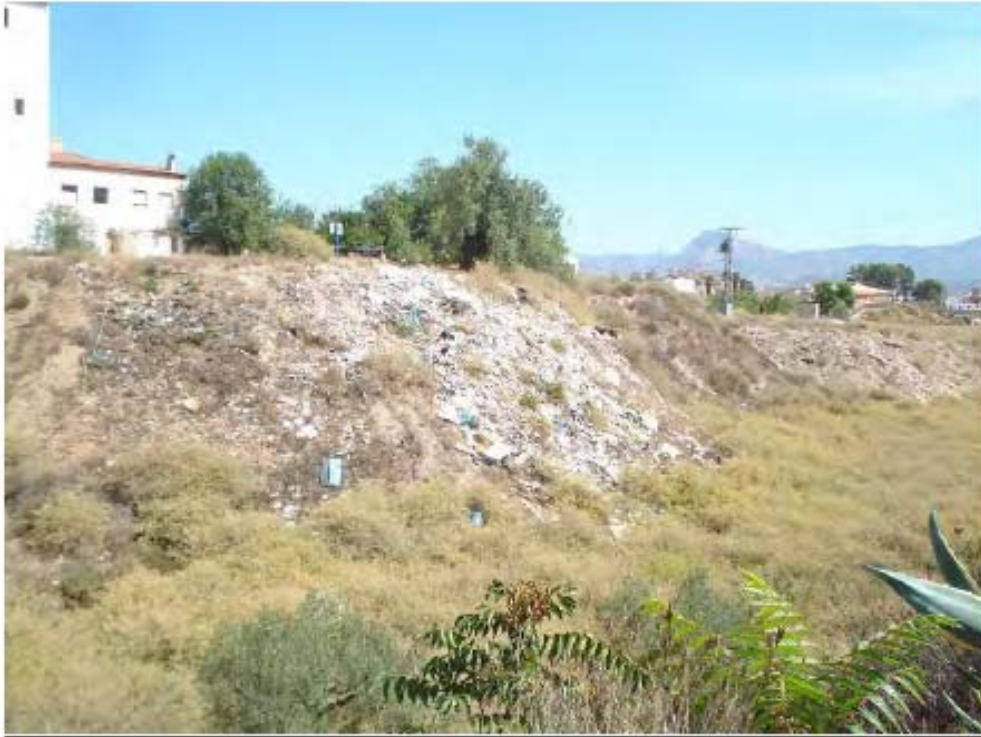
Estado de la abundantes RSI en el talud de la margen izquierda.
