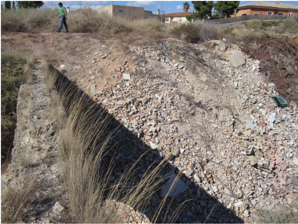
Estado inicial del talud junto acueducto existente.
