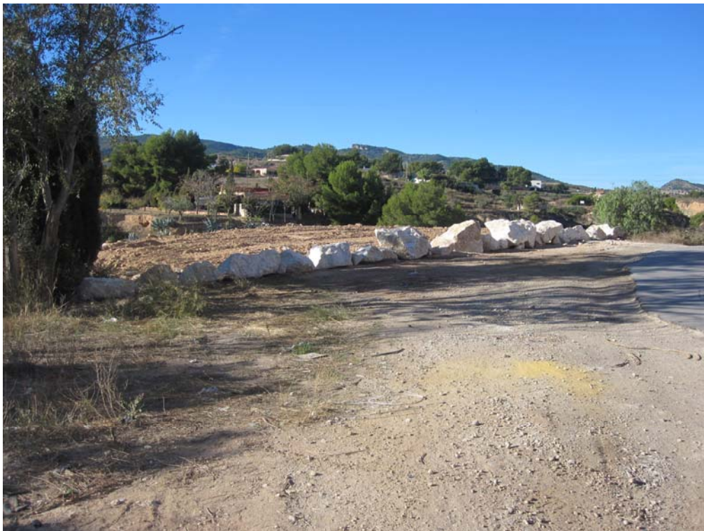
Vista barrera de rocalla para impedir el paso de vehículos a las zonas de vertido.
