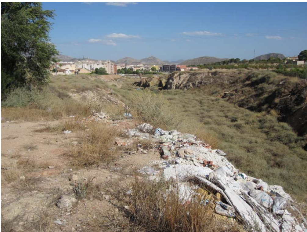
Aspecto inicial de la coronación del talud antes de actuar.
