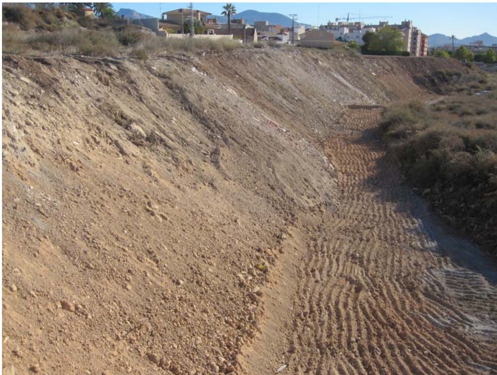
Vista general de los trabajos finalizados.
