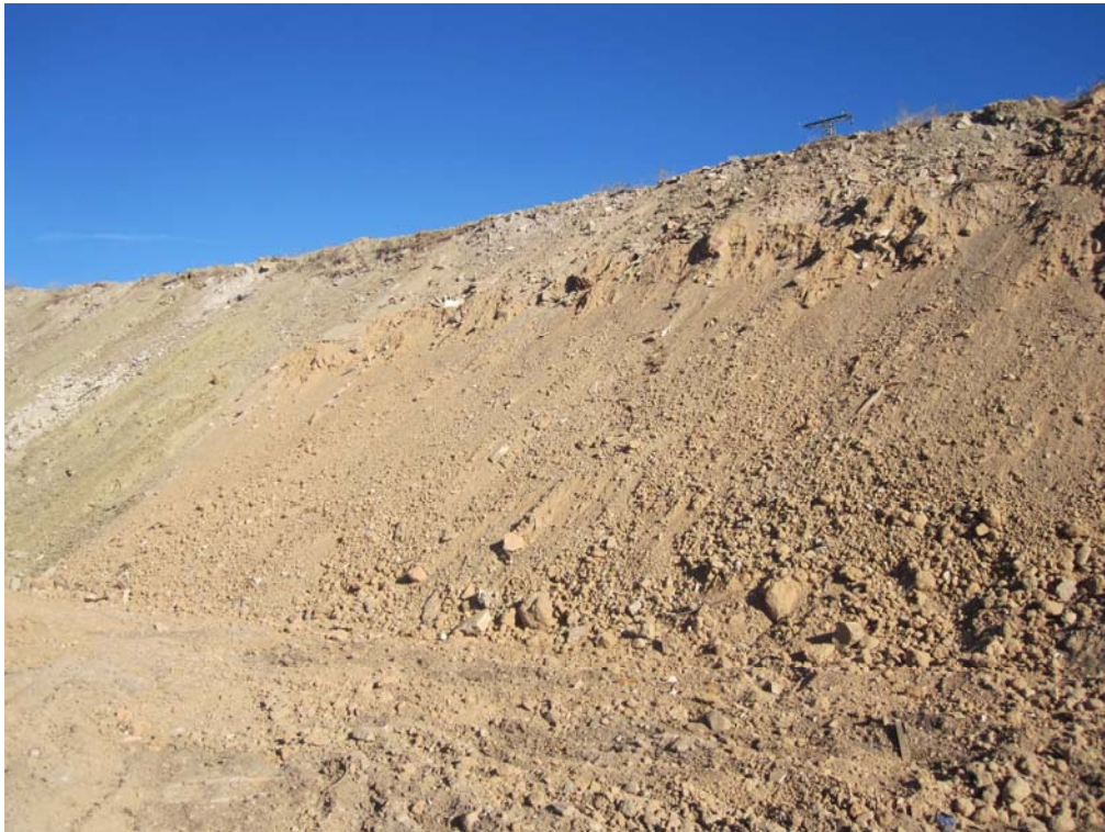
Aspecto final de los taludes y lecho del cauce.
