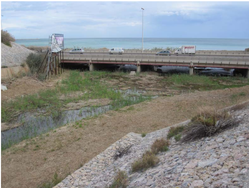
Estado final de la zona de desembocadura tras el tratamiento del carrizal.
