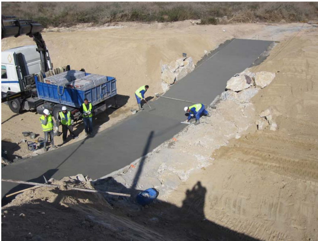
Detalle de la construcción del badén.
