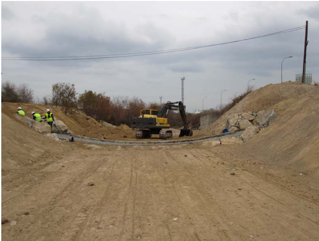
Construcción de badén donde existía un dique de escombros y retaluzado de la sección.
