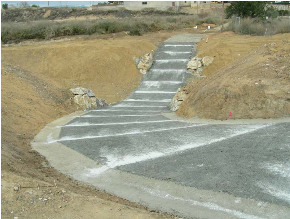
Aspecto del badén finalizado.
