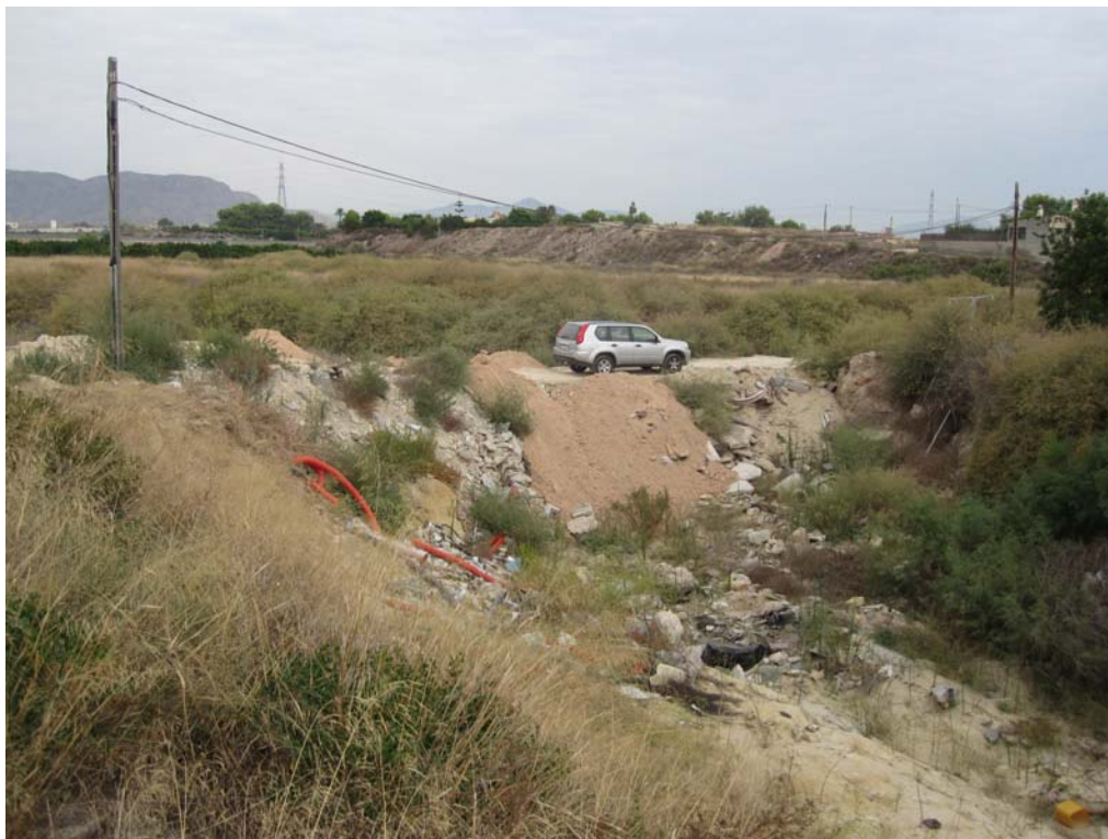
Dique de escombros que facilitaba el cruce de vehículos sobre la rambla.
