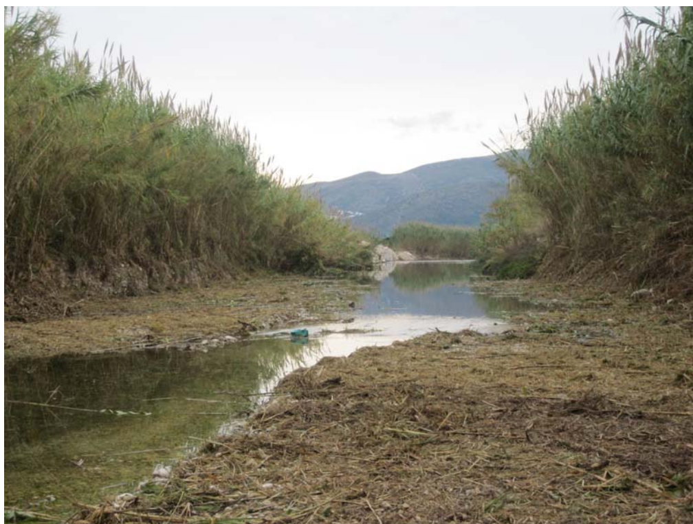
Estado del mismo tramo de cauce tras la eliminación del cañar.
