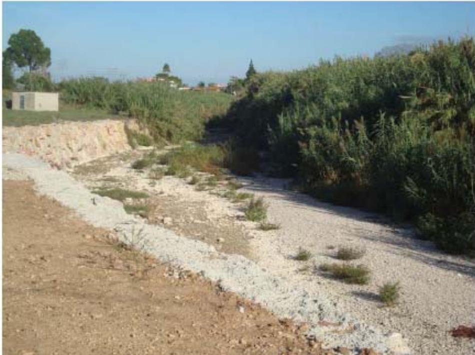
Estado del cañar antes de la actuación.
