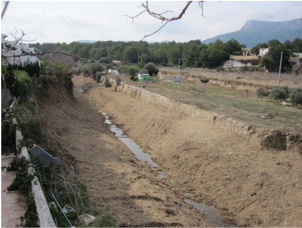
Estado del cauce tras el desbroce del cañar.
