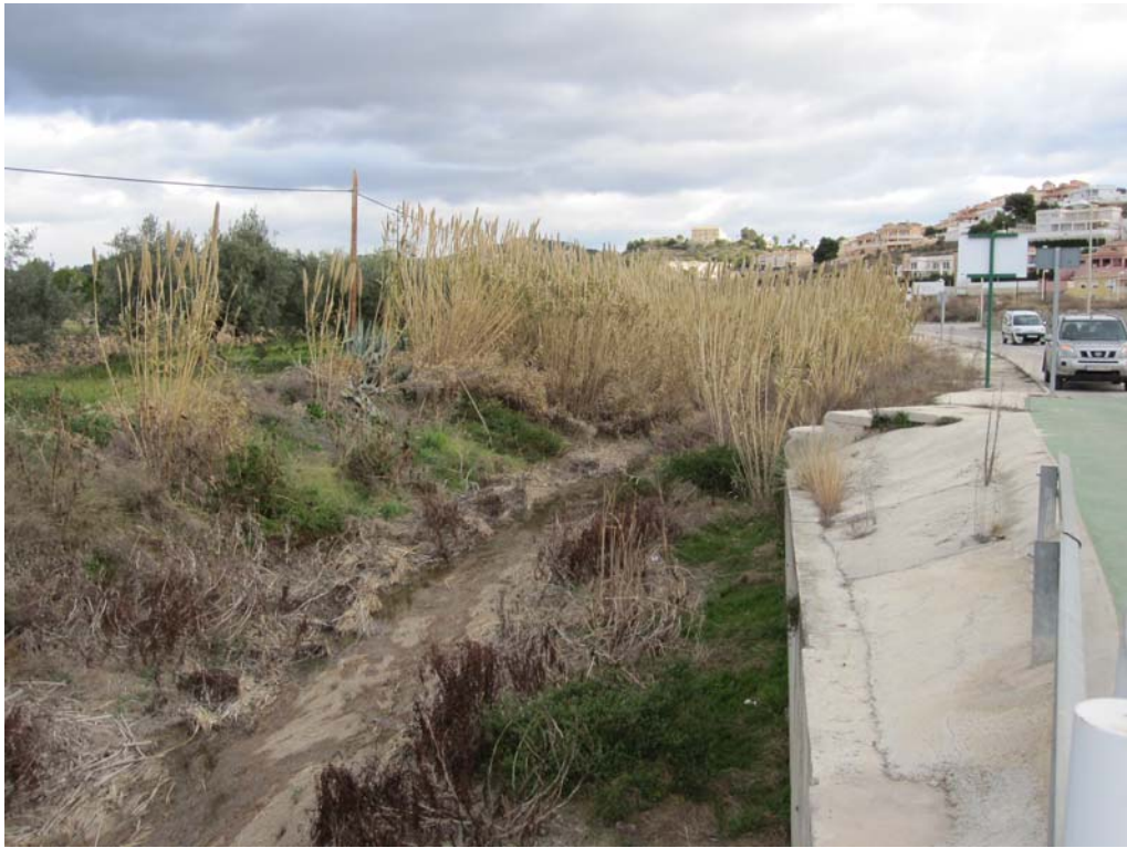
Aspecto general del cauce antes de los trabajos realizados.
