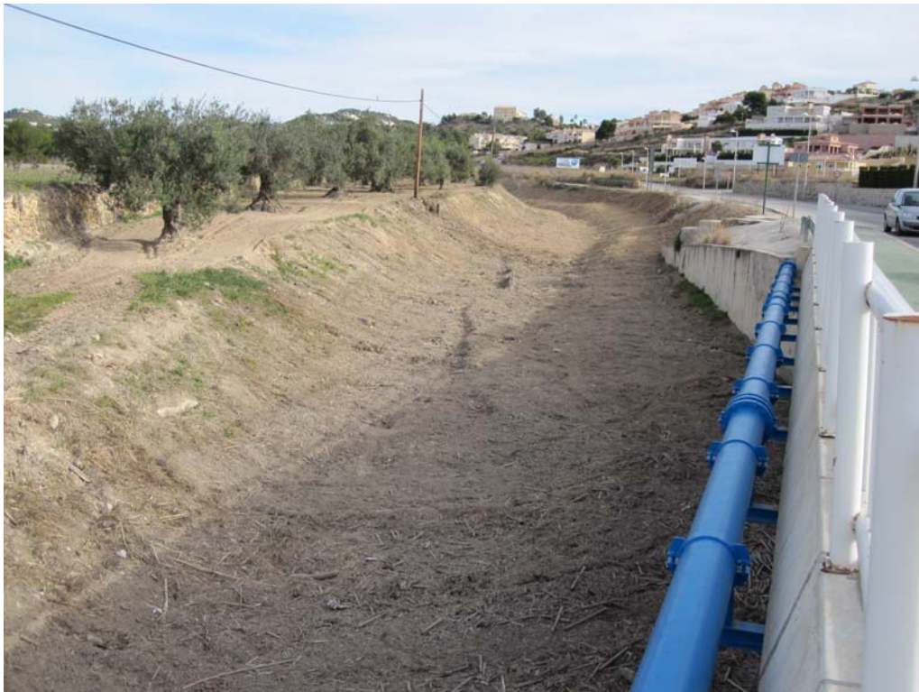
Aspecto general del cauce tras finalizar los trabajos
