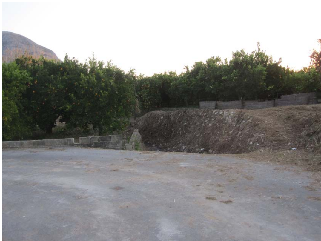
Vista del mismo punto tras realizar los trabajos de desbroce.
