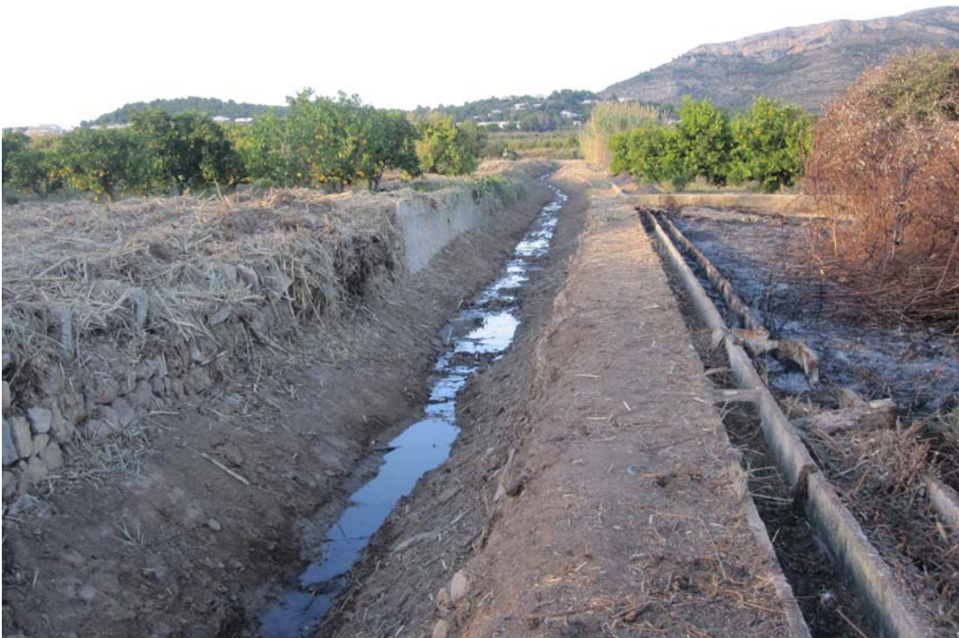
Aspecto tras realizar las labores de desbroce del cañar.
