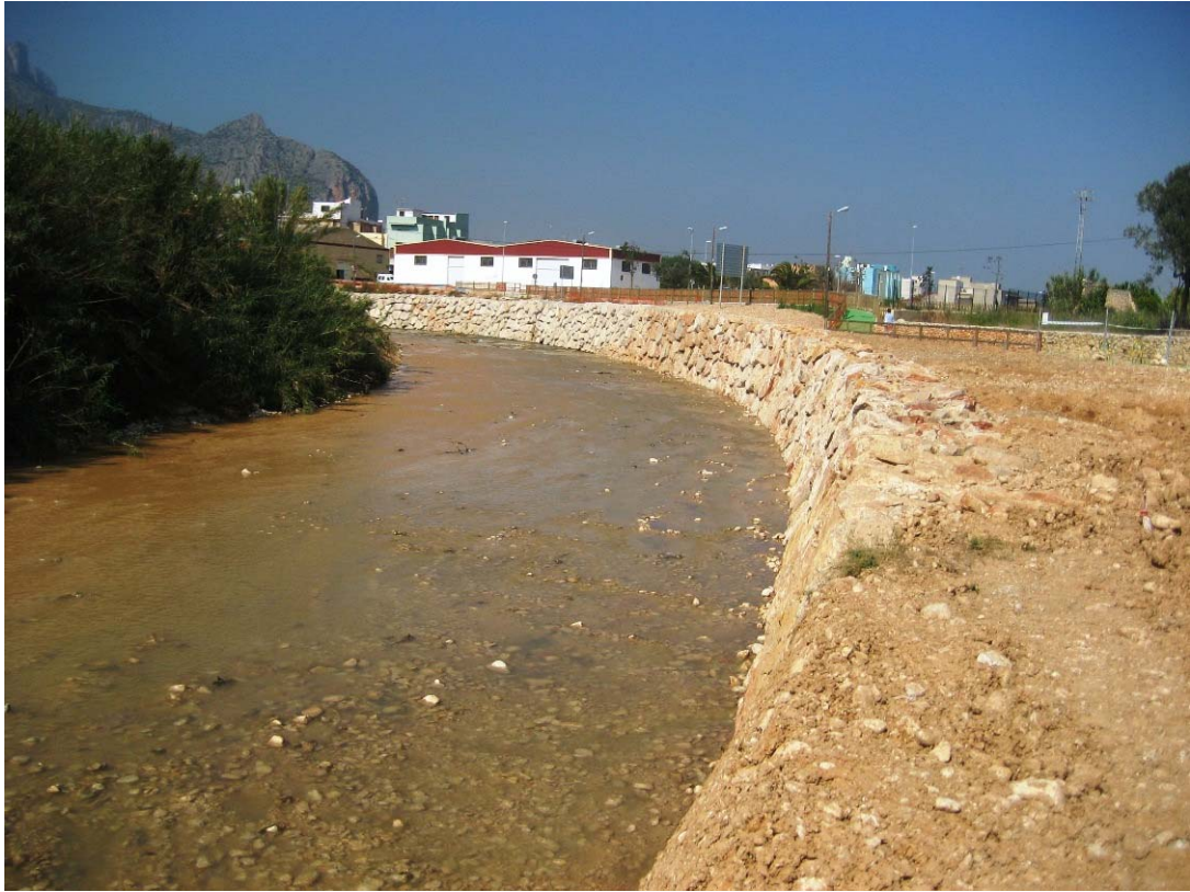
Estado del tramo tras los trabajos
