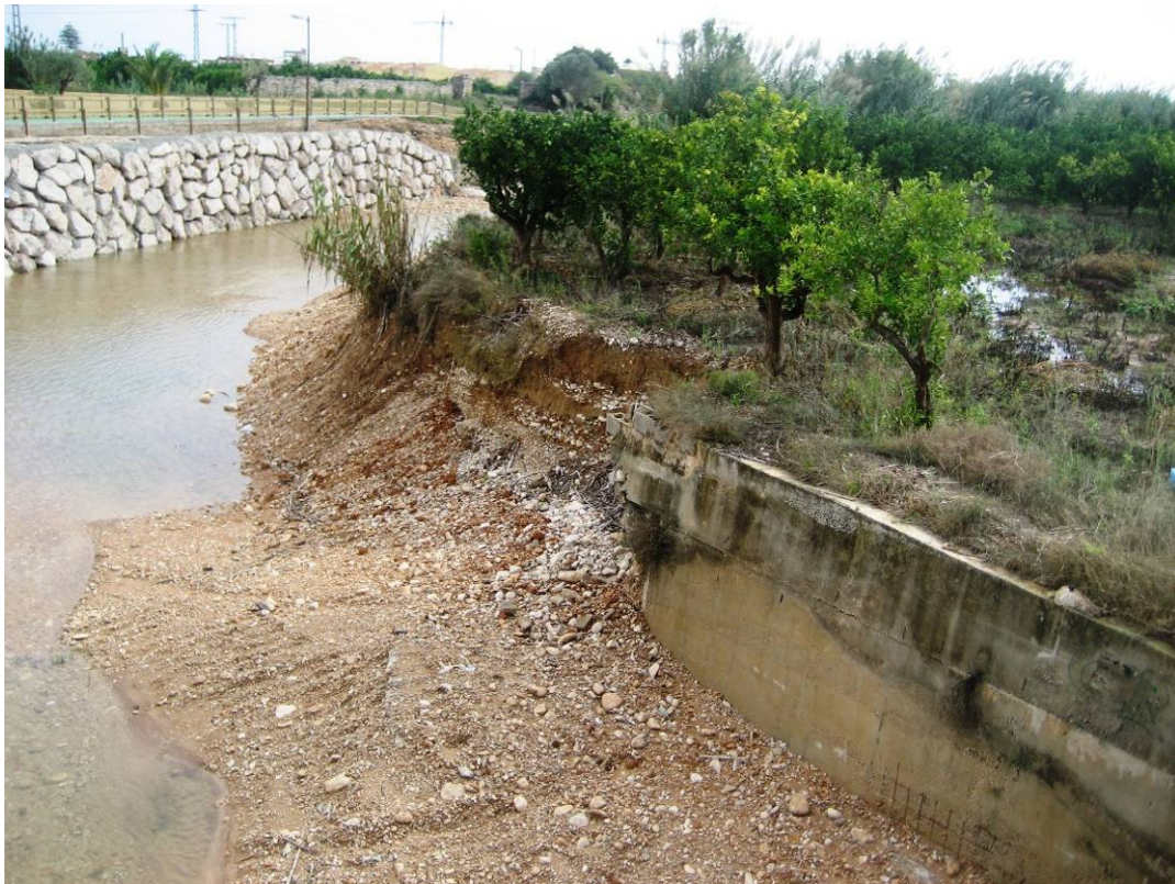
Estado del tramo antes de los trabajos
