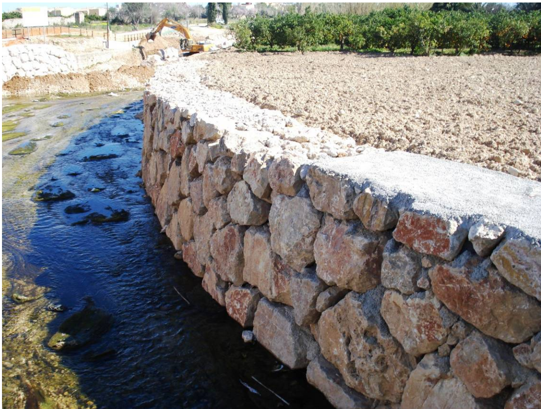
Estado del tramo tras los trabajos
