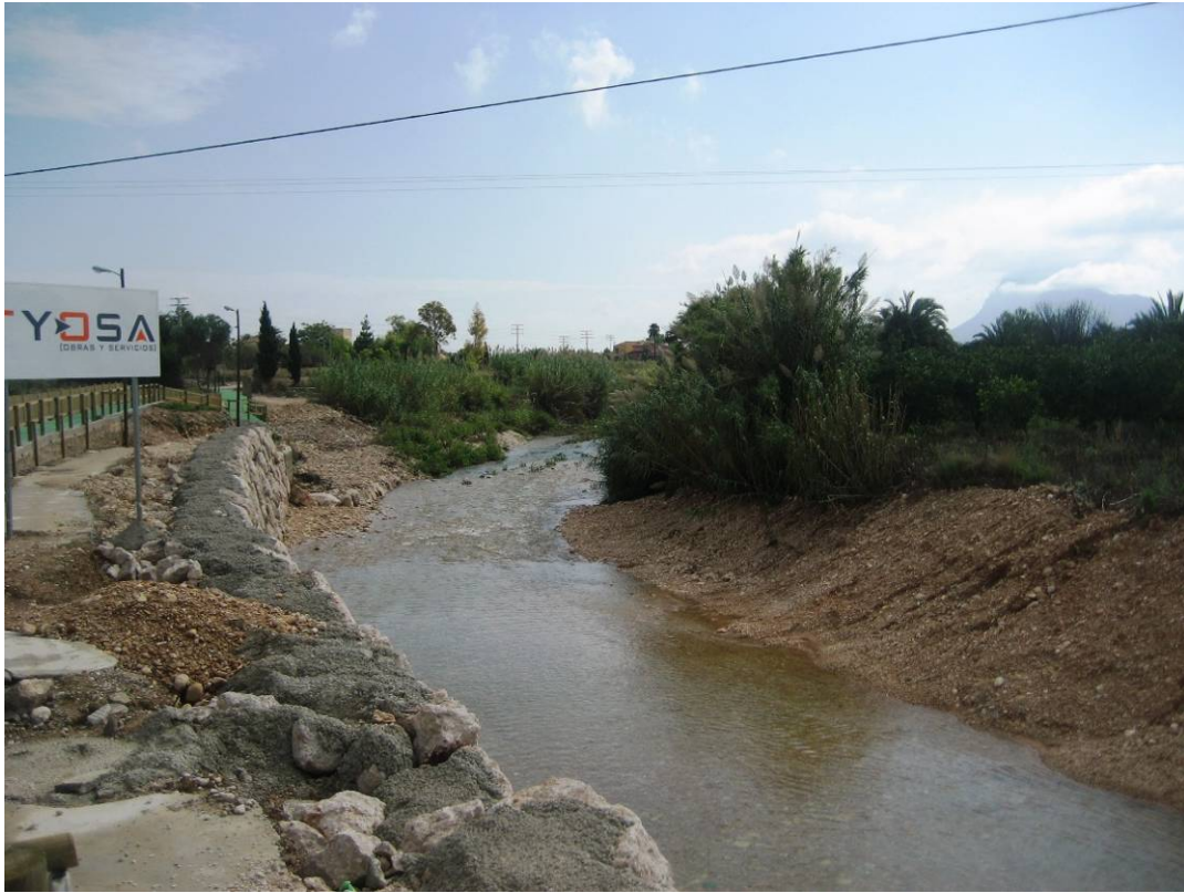
Estado del tramo antes de los trabajos
