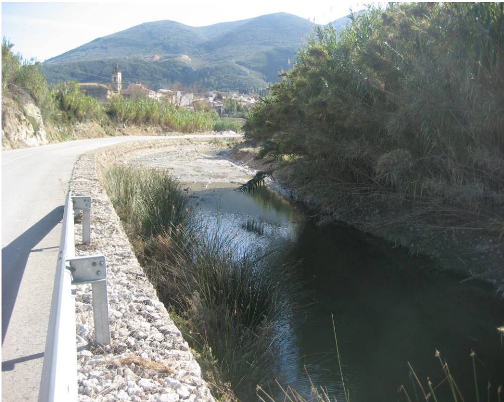
Aspecto del mismo tramo del cauce, tras los trabajos.
