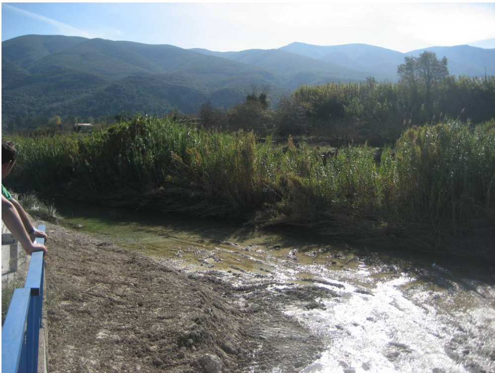
Aspecto del mismo tramo del cauce, tras los trabajos.
