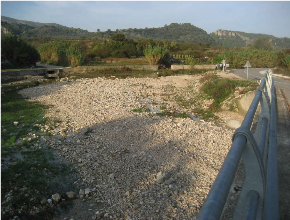
Aspecto de un tramo del cauce, antes de los trabajos.
