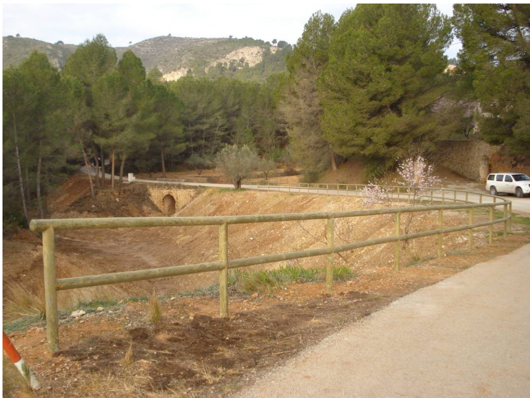
Aspecto del vertedero ilegal tras los trabajos descritos.
