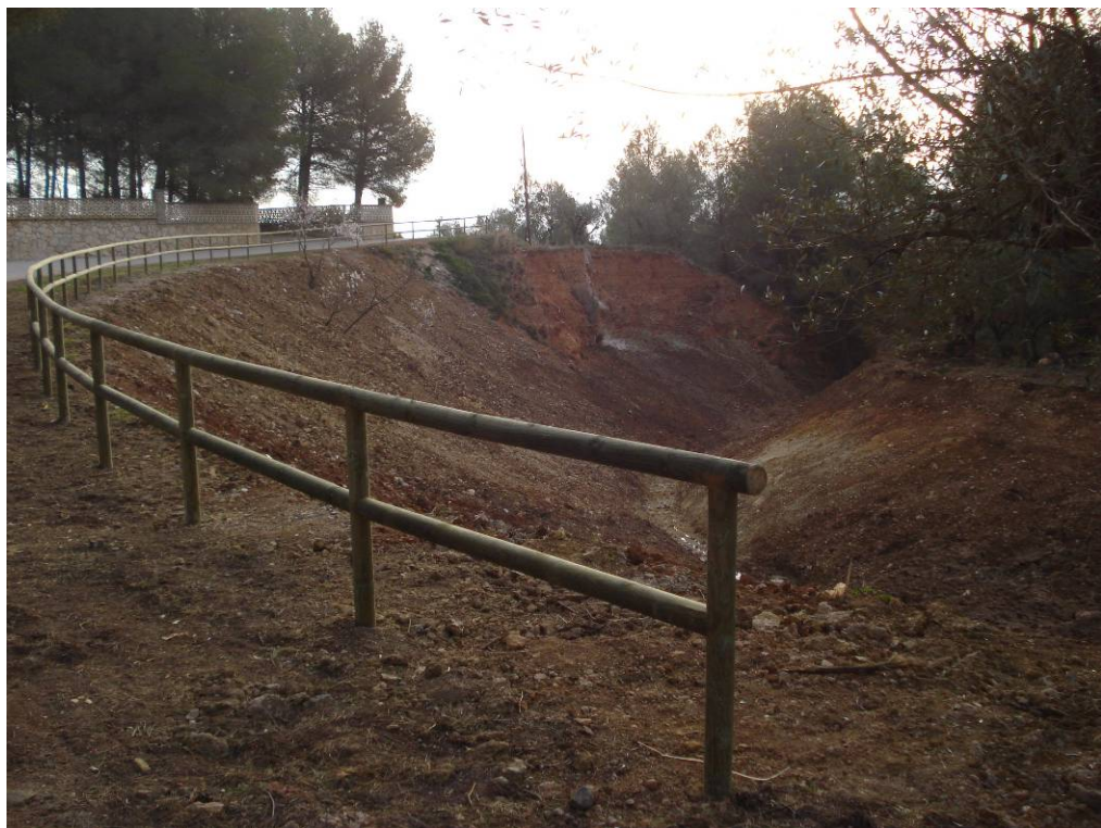
Aspecto de este tramo de cauce tras los trabajos descritos.
