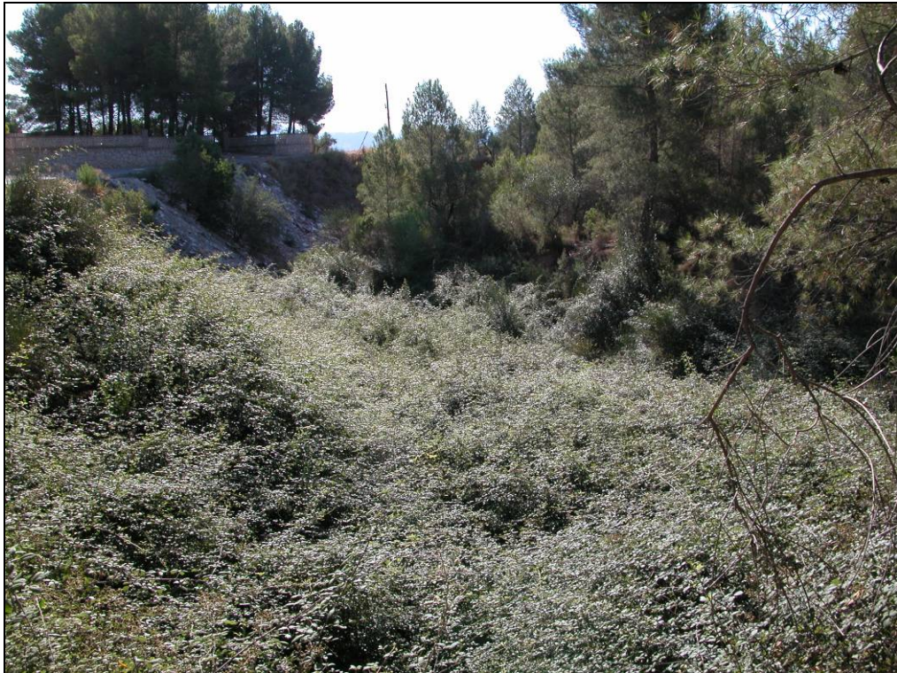
Aspecto de este tramo de cauce antes de los trabajos descritos.
