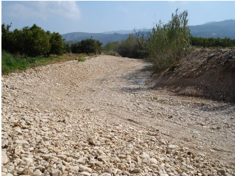
Estado final del mismo tramo de cauce tras los trabajos.
