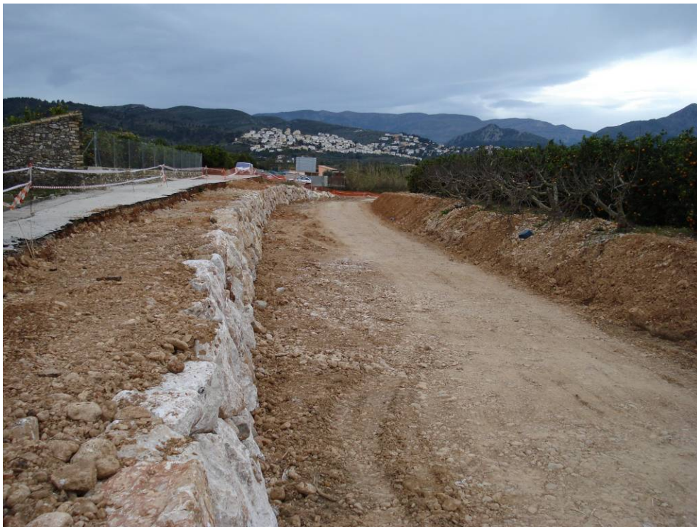
Estado final del mismo tramo tras los trabajos.
