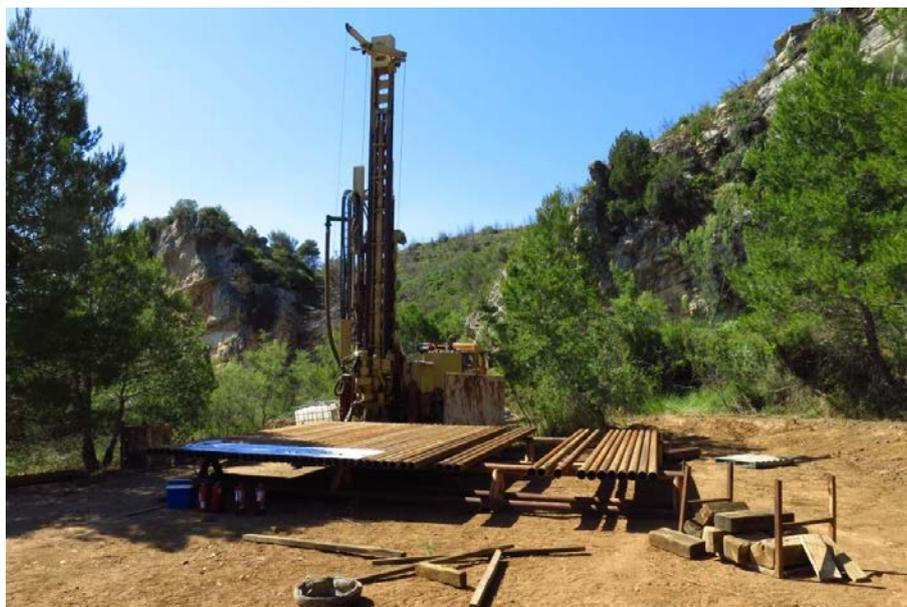
Figura 80. Sondeo de investigación previo a la ejecución de batería de pozos de sequía en la cola del embalse de Forata. (Fuente: CHJ, 2016).
