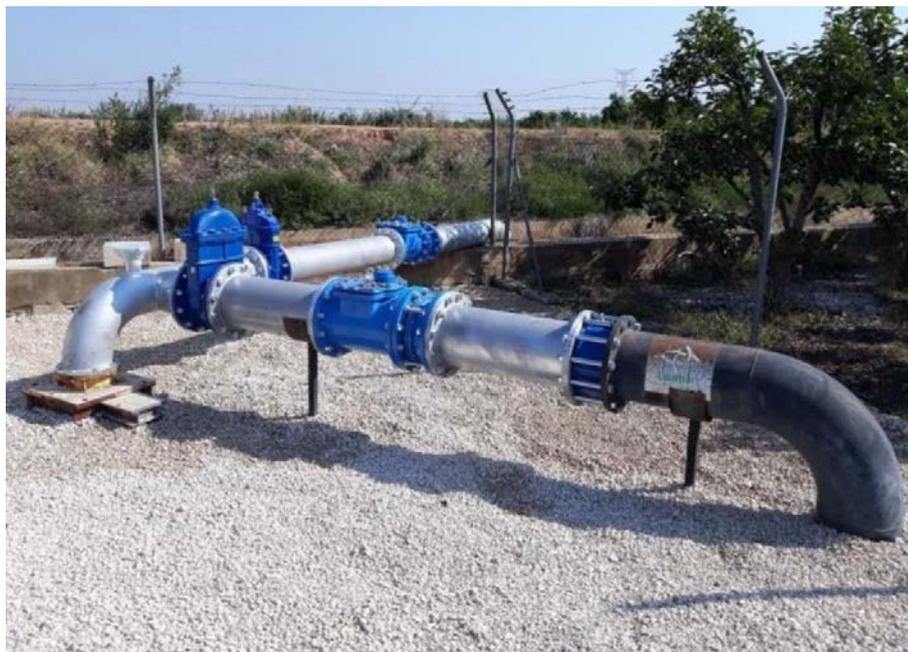
Figura 84. Renovación de valvulería y elementos de control de la red de pozos de sequía en el Bajo Júcar. (Fuente: CHJ, 2018b).
