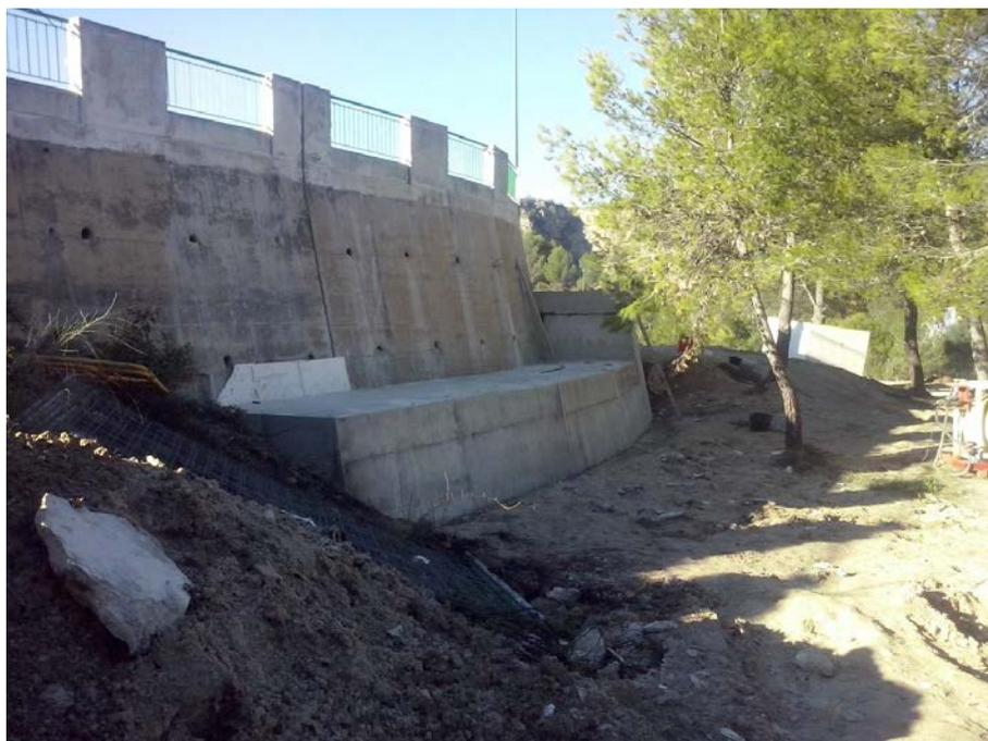
Figura 79. Consolidación del cemento en el estribo derecho de la presa de Beniarrés. (Fuente: CHJ, 2015-2016).
