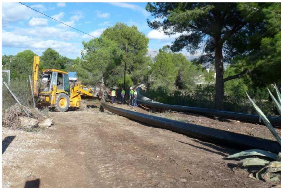
Figura 82. Montaje de la tubería de reutilización sobre el Canal Bajo del Algar. (Fuente: CHJ, 2015-2016).
