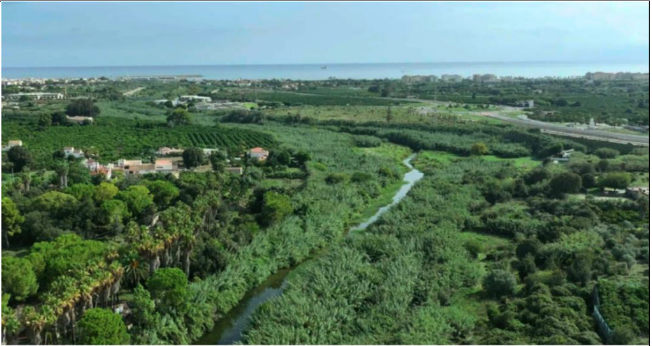
b) Fin de la Fase 1: tras la instalación de la cobertura en la fase 1
