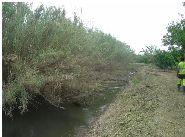
*Figura 3. La situación actual del tramo requiere la apertura de los pasos de agua y puentes por lo que discurre el barranco. Se pretende, con ello, evitar posibles obturaciones que deriven en cortes de carretera, derribo de puentes, etc.*
