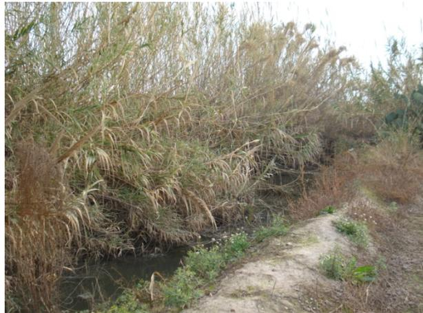
*Figura 2. En alguna parte de los tramos se observa la colmatación completa del canal de desagüe. Por tanto, se requiere el dragado de estos tramos con la posterior restauración de las motas y taludes de protección del cauce.*
