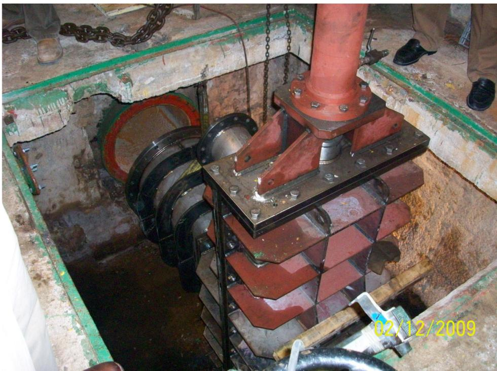
Sustitución de la compuerta en la Cota 90
