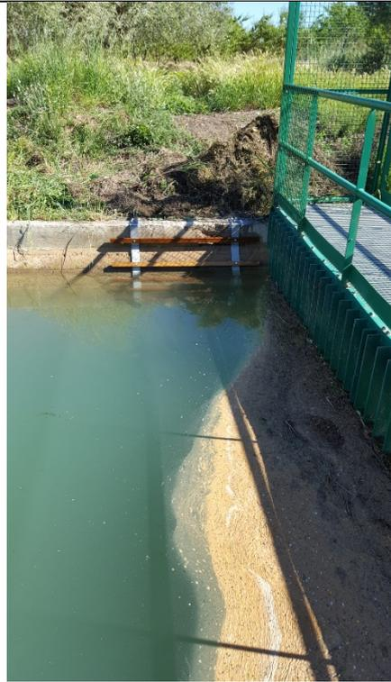
*Instalación de escalones de madera en el talud izquierdo de la toma de la Hoya del Canal Principal del Campo del Turia (Valencia)*
