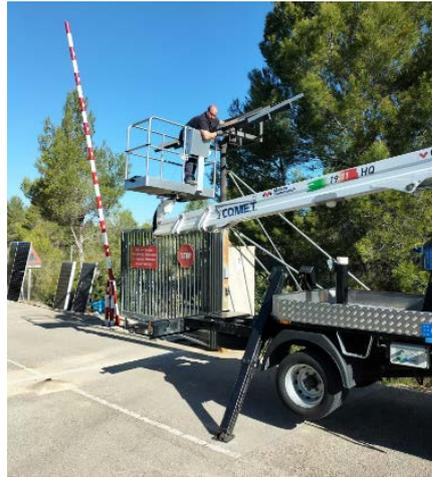
*Instalación de placas fotovoltaicas y baterías de litio en puertas de acceso a la presa de Escalona.*
