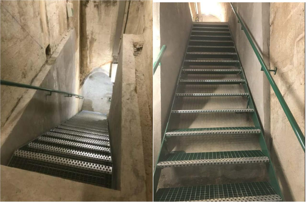
*Demolición de escalera de caracol y ejecución de nueva escalera de acceso a toma de agua de la presa de Beniarrés*
