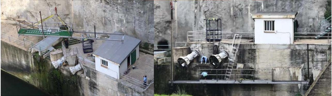
*Fabricación e instalación de plataforma deslizante para revisión de válvulas Howell-Bunger de la presa de Beniarrés.*
