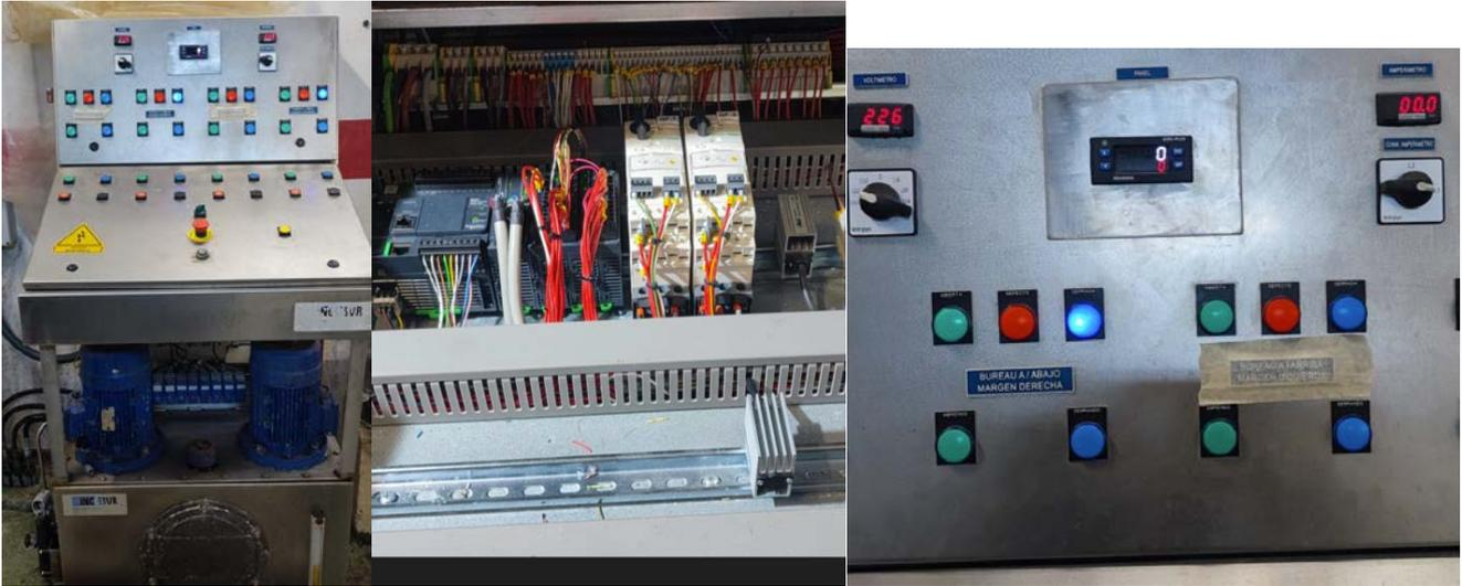
*Revisión de pupitre de accionamiento de las compuertas Bureau del desagüe de fondo de la presa de Amadorio, instalación de PLC y display.*
