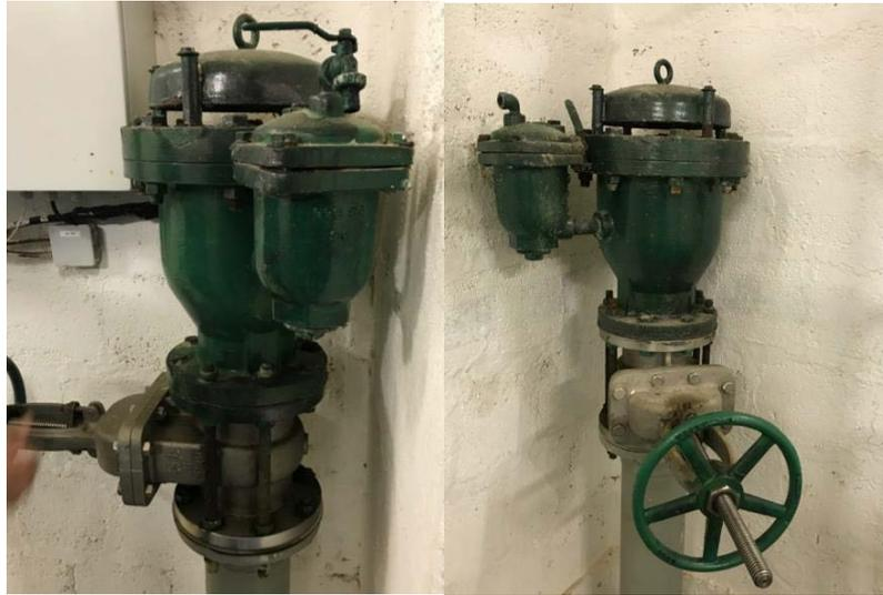
*Reparación de enclavamiento de cilindro oleohidráulico de accionamiento de la compuerta Bureau de la toma de agua de la presa de Beniarrés. Adecuación de la ventosa de la toma de agua.*
