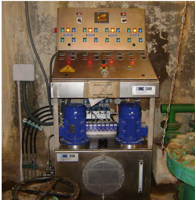
*Revisión de centrales oleohidráulicas del desagüe de fondo de la presa de Amadorio*
